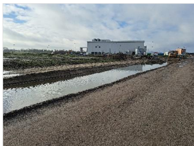
Figuur 2.6 Watergang ten noordwesten van de onderzoekslocatie (kijkrichting: zuidwest).
