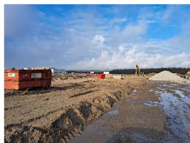
Figuur 2.5 Impressie van de onderzoekslocatie (kijkrichting: noordwest).
