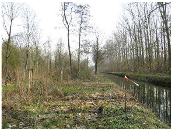
Figuur 15. Het tracé van het geluidsscherm was in het veld al gemarkeerd met vlaggetjes (03-03-2021).
