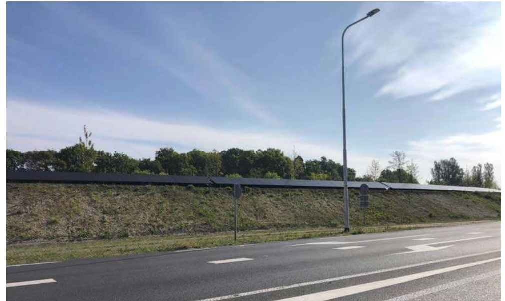
Voorbeeld zonnepanelen op geluidwal (locatie: N303 Voorthuizen)
