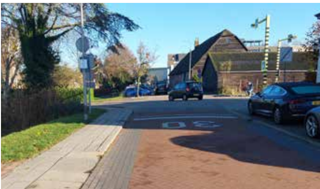
Foto huidige situatie: kruising Lagendijk - Centrumring
