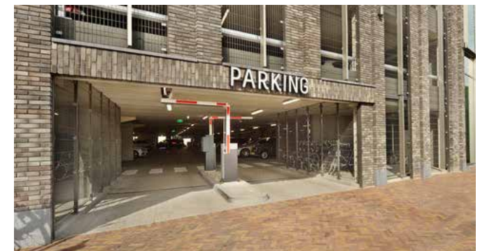
De inrit naar de parkeergarage past in het gevelbeeld (nr.6)
