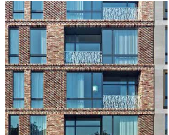
De horizontale banden benadrukken de maat van het blok, de verticale penanten zorgen voor een kleinschaliger ritme (nr.28)
