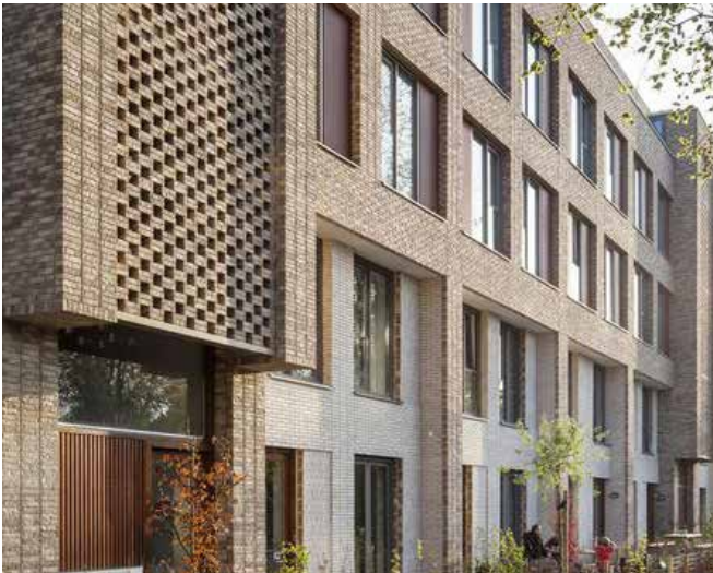
Een gelaagde gevel in 2 kleuren metselwerk met verbijzonderingen in het metselwerk (nr.23)
