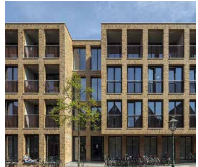
Gelaagde gevel van metselwerk (nr.7)
