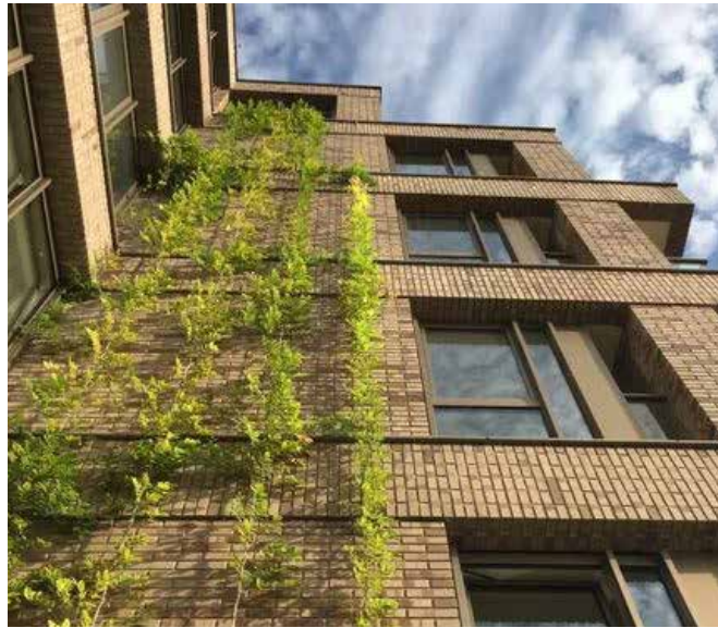
Gevel met verticale lijnelementen gevelgroen (nr.6)
