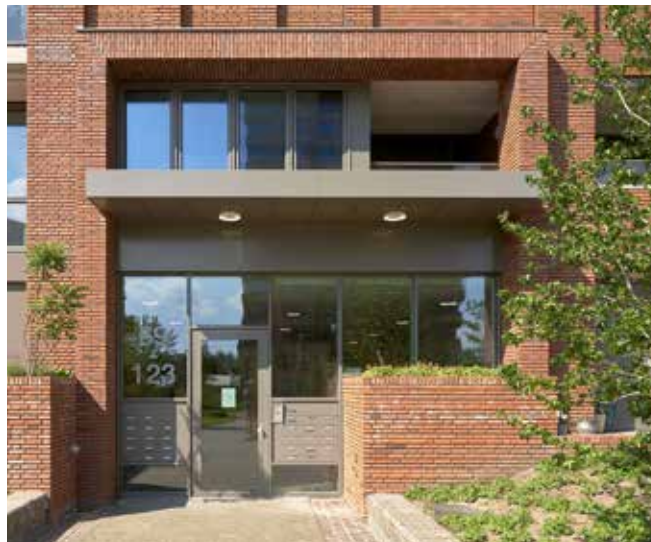
De royale hoogte, luifel met verlichting en in de gevel opgenomen bakken voor groen maken de entree uitnodigend (nr.1)
