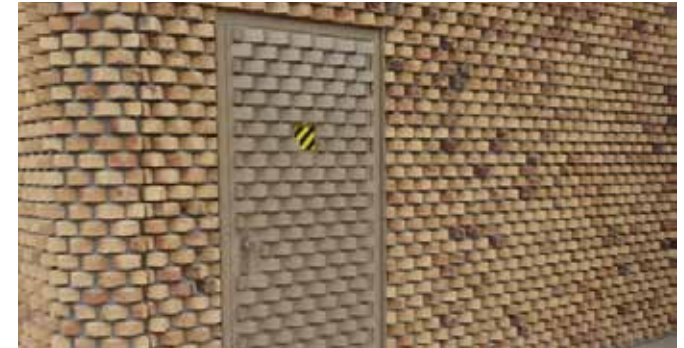
Referentiefoto: trafo-ruimten geïntegreerd in het gebouw (nr.29)
