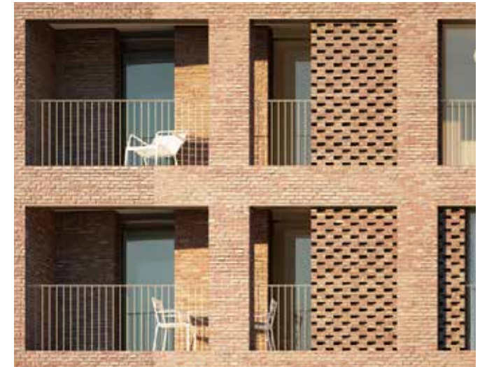
Een gelaagde gevel met verschillende metselverbanden geeft maat en schaal en verrijkt het gevelbeeld (nr.26)
