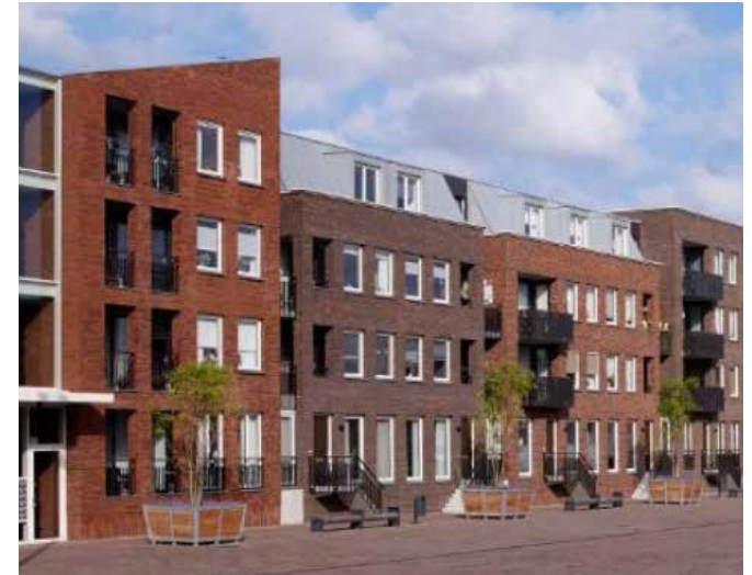
Geleed bouwblok met teruggelegde dakverdieping, dansende daklijn, verspringende rooilijn en verschillende kleuren metselwerk (nr.10)
