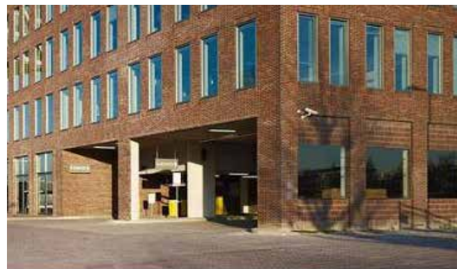
Referentiefoto: inrit parkeergarage ingepast in het gevelbeeld (nr.2)
