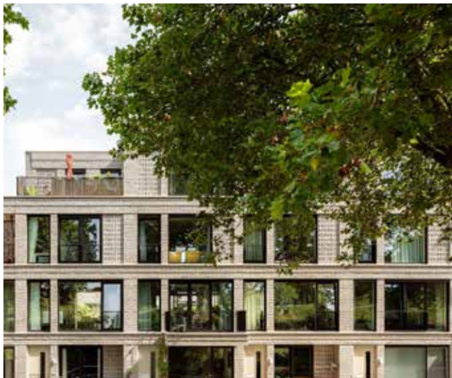
De horizontale banden benadrukken de maat van het blok, de verticale penanten geven het gebouwen een kleinschaliger ritme (nr.5)
