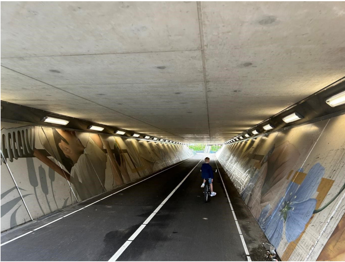
Foto 2: Tunnel IJsselmondse knoop
