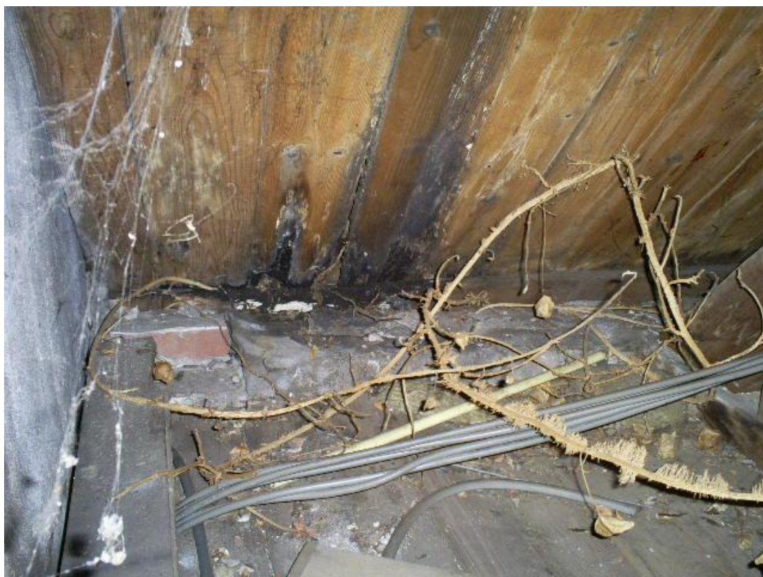
Dakbeschot aangetast
