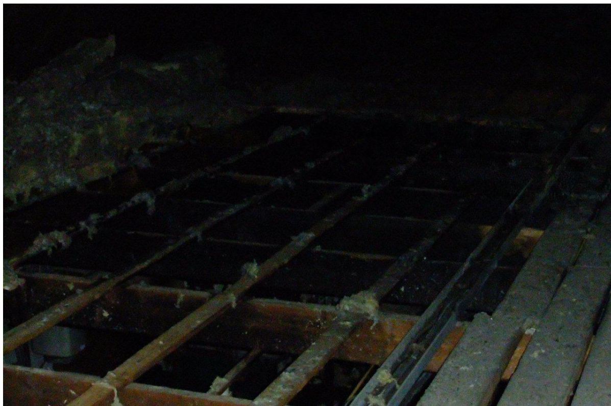
Brandschade zolder balklaag ontbreken thermische schil en vloerbeschoot.
