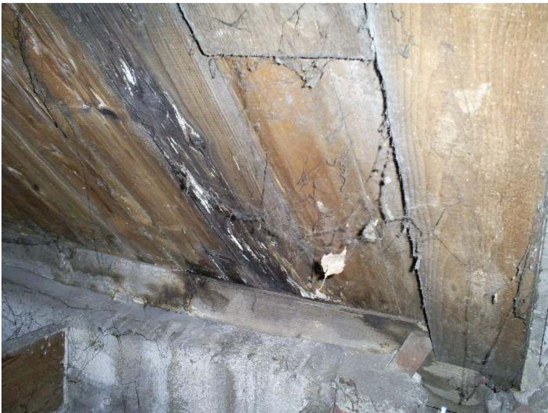
Dakbeschot aangetast
