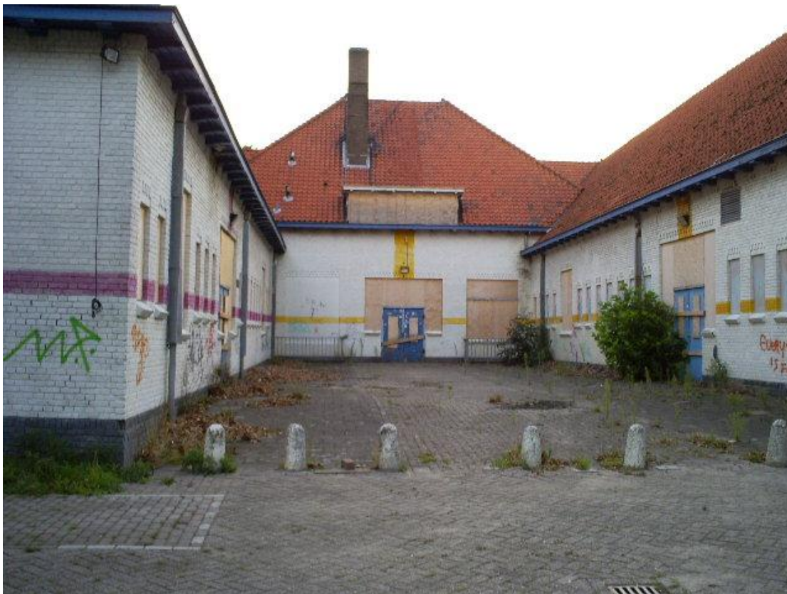
Schilderwerk gevelmetselwerk achtergevel aanzicht schoorsteen
