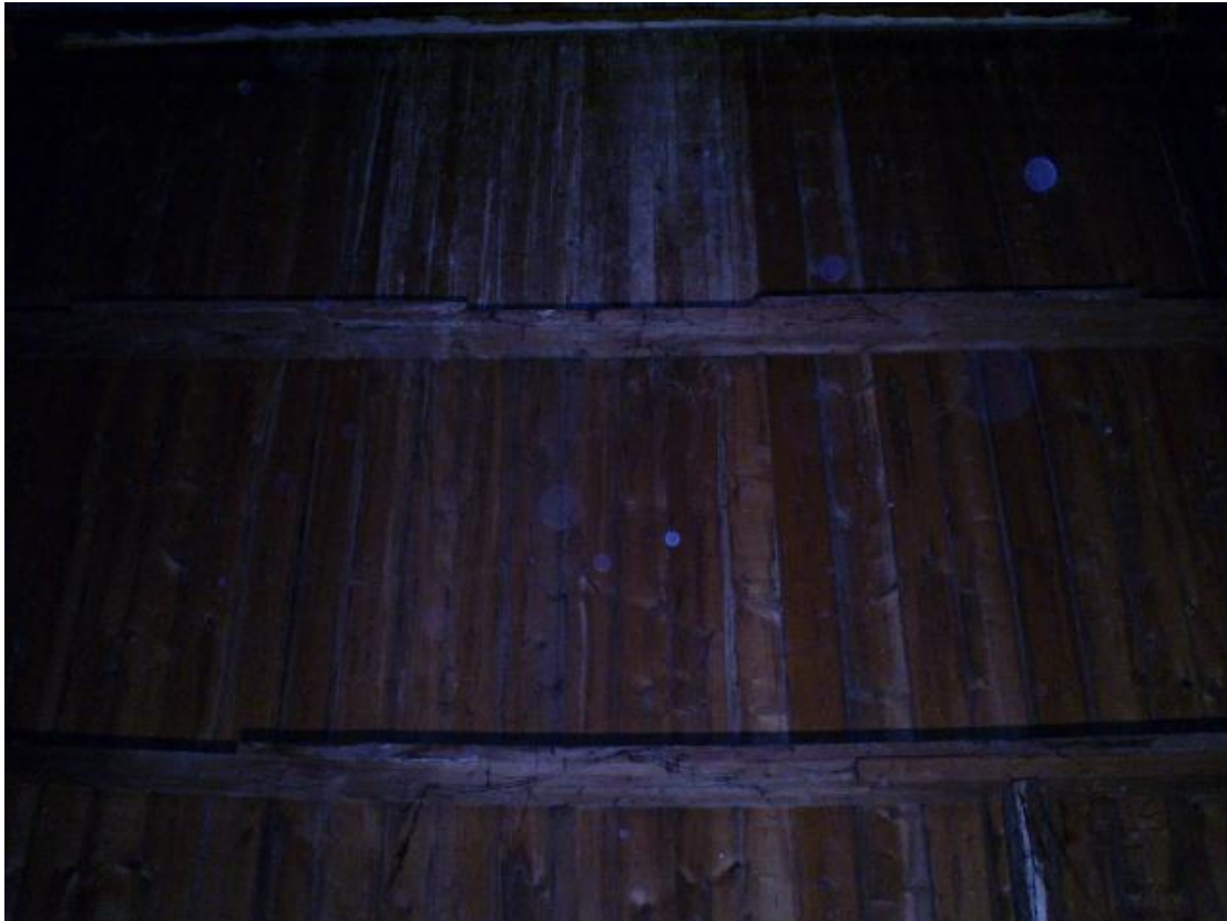
Doorhangende gordingen kapconstructie boven dakkappel
