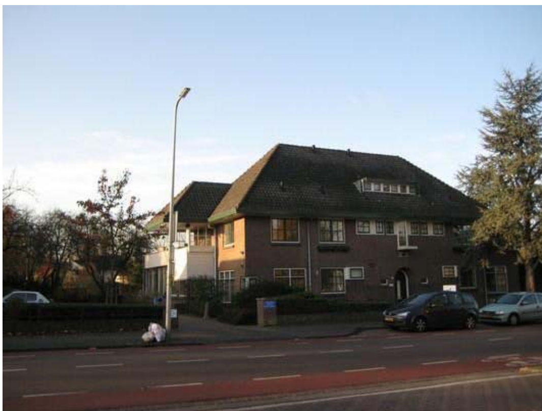
Foto: kantoorvilla Kievitsweg 71
