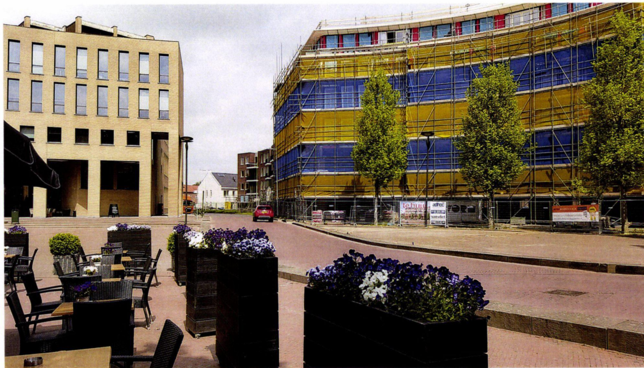
Koningsplein wordt afgebouwd
