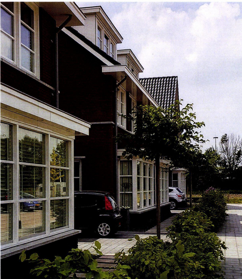
Nieuwbouw Het Nieuwe Zand 4
