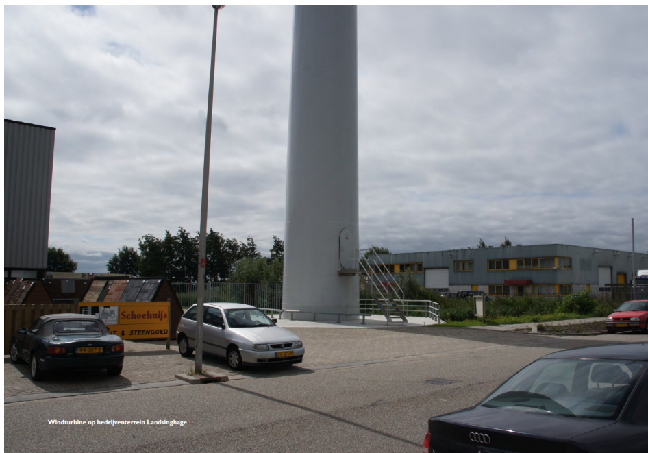
Afbeelding 2 Windturbine (ashoogte 80 m, rotor 90 m) op bedrijventerrein in Zoetermeer 13
