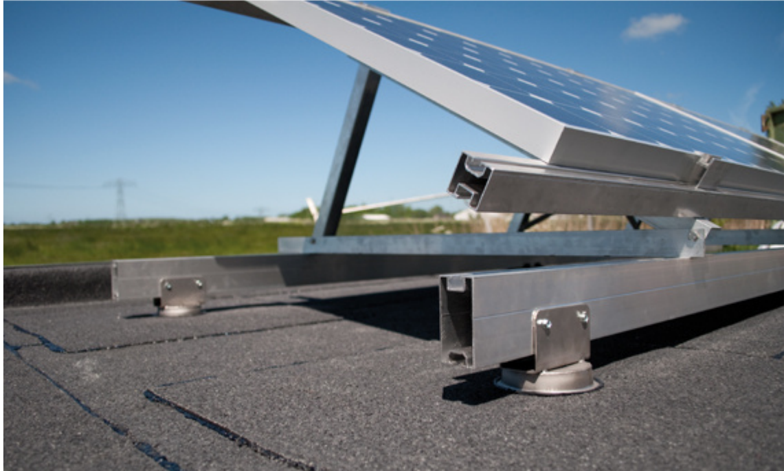
Afbeelding 8 Montagesysteem met vaste bevestiging aan dak
