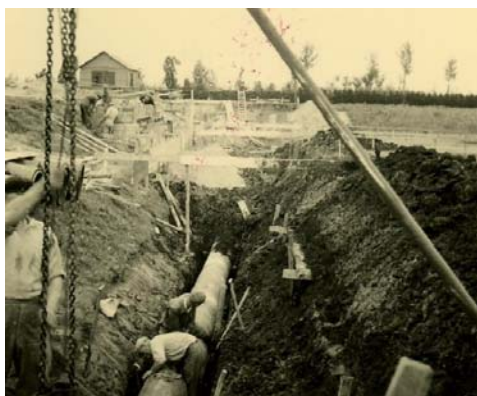
Aanleg riolering begraafplaats Lagendijk
