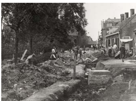
Aanleg riolering Benedenrijweg
