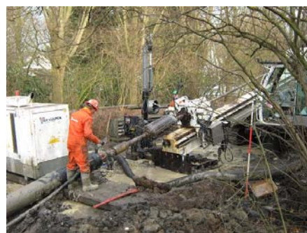
Aanleg persleiding Rijsoord - Bilderdijklaan
