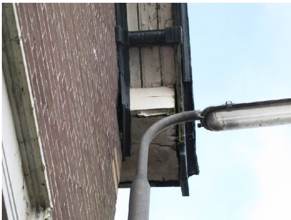
Figuur 4. Voor vleermuizen toegankelijke ruimte achter betimmering.
