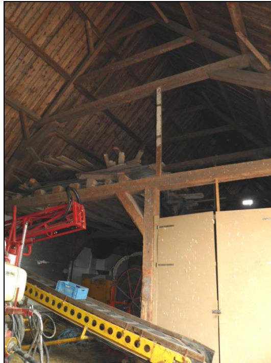
Figuur 4. Een deel van de schuur wordt gebruikt als opslagruimte.
