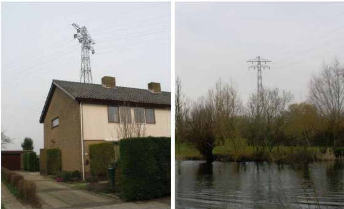
50 KV Hoogspanningsverbinding Slikkerveer-Walburg
