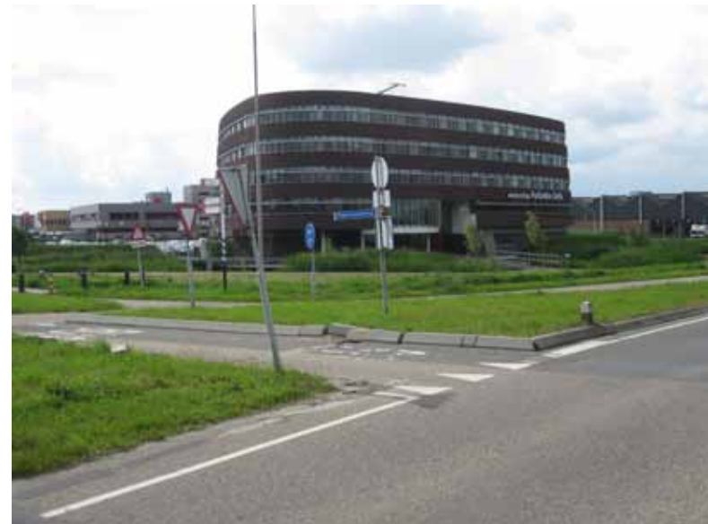
Waterschapsgebouw als referentie
