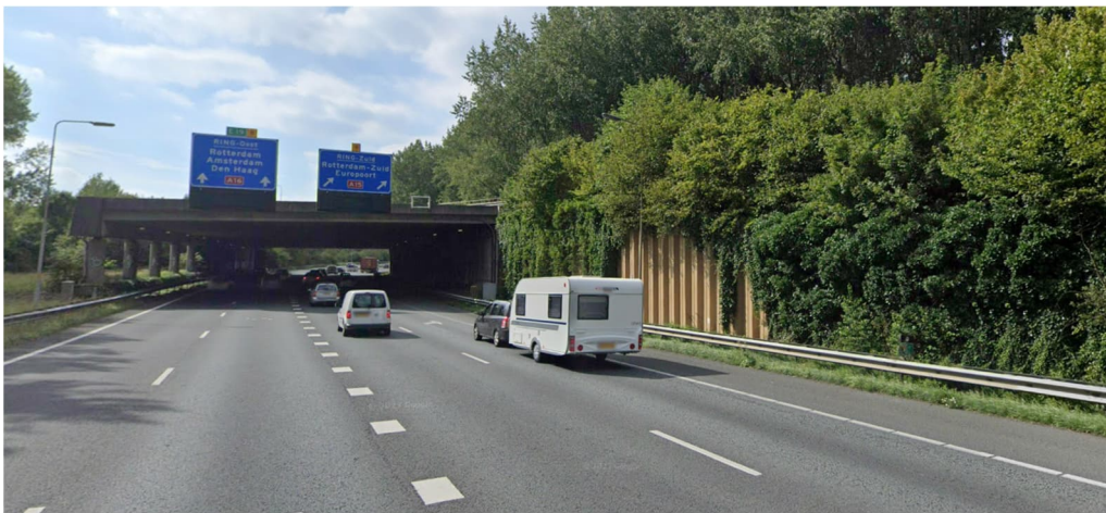
figuur 2: aanzicht overkluizing en fly-over A15 (bron: Google StreetView)
