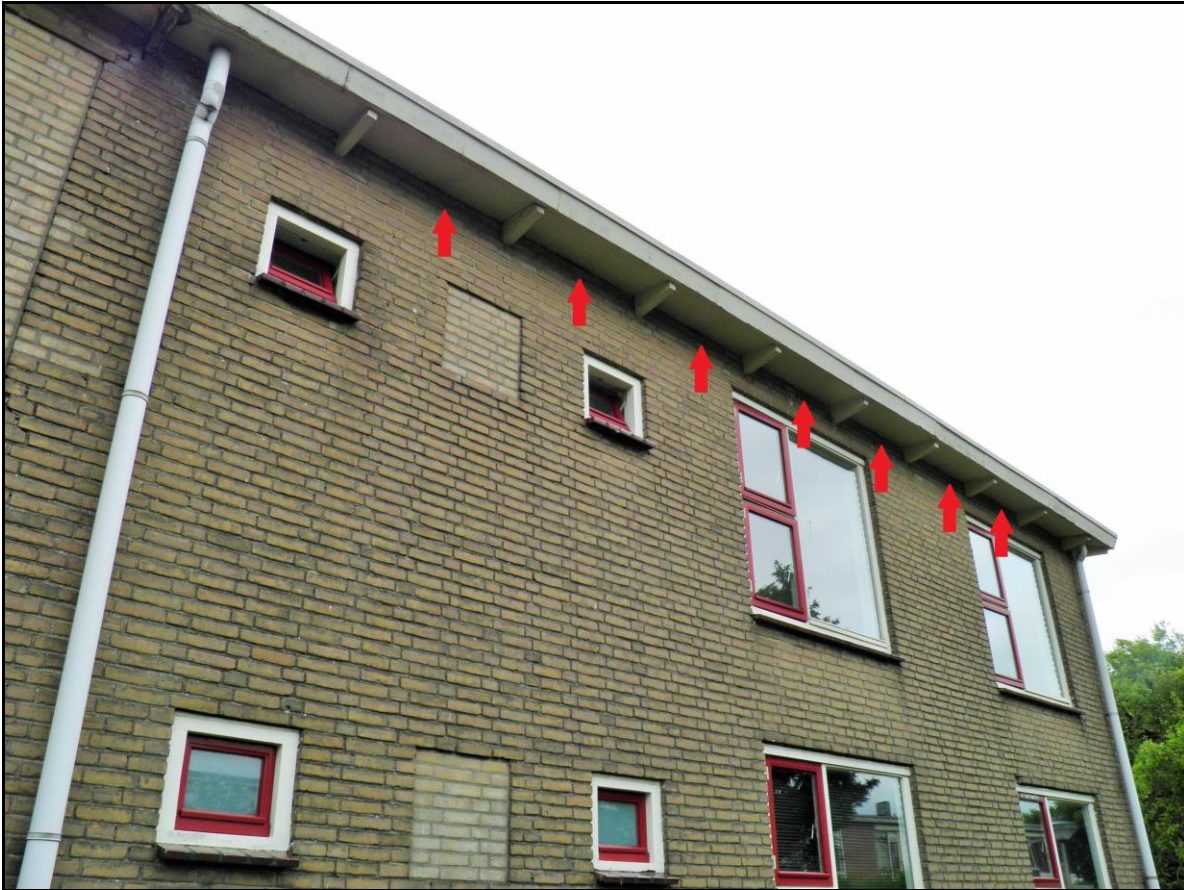
Figuur 7. De nestopeningen van de Gierzwaluwen aan het gebouw van het Burgemeester Nieuwenhuisenplein zijn aangegeven met rode pijlen.
