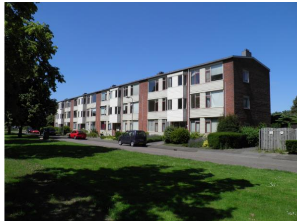
Figuur 3. Het noordelijke deel van het onderzoeksgebied wordt gekenmerkt door 2-3 laag appartementencomplexen, zoals hier bij de Hovystraat.
