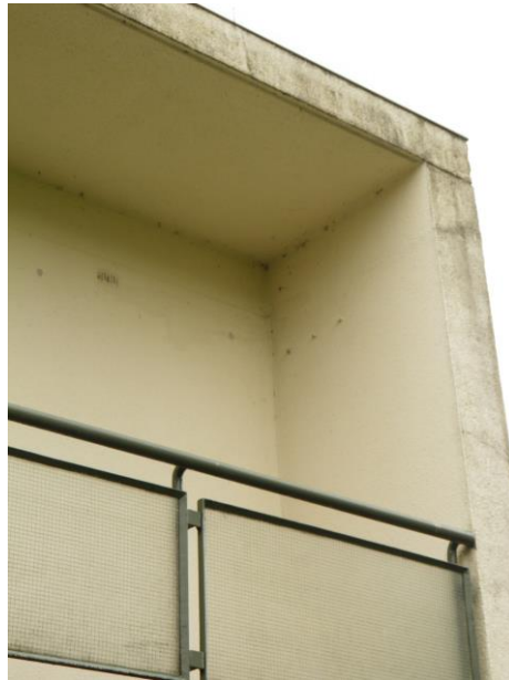
Figuur 4. Detailopname van de muren en daklijst.
