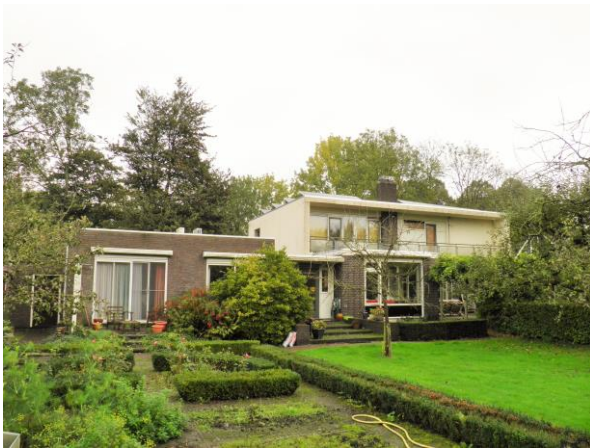
Figuur 2. Achterzijde van de woning met links de aanbouw.
