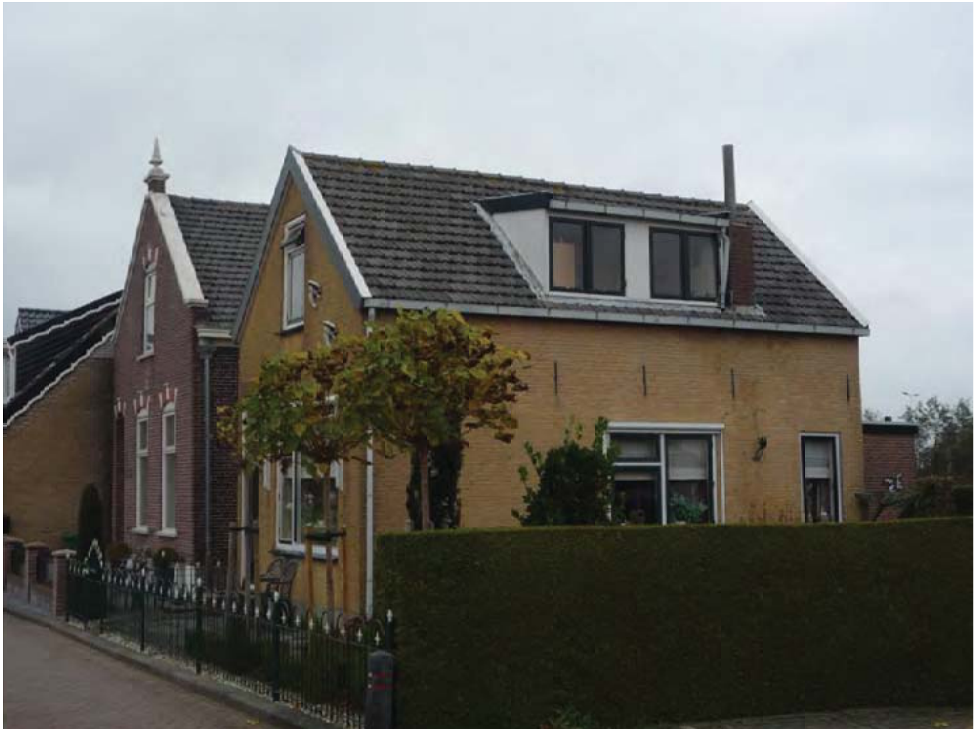
Damstraat 9 rechter zijgevel
