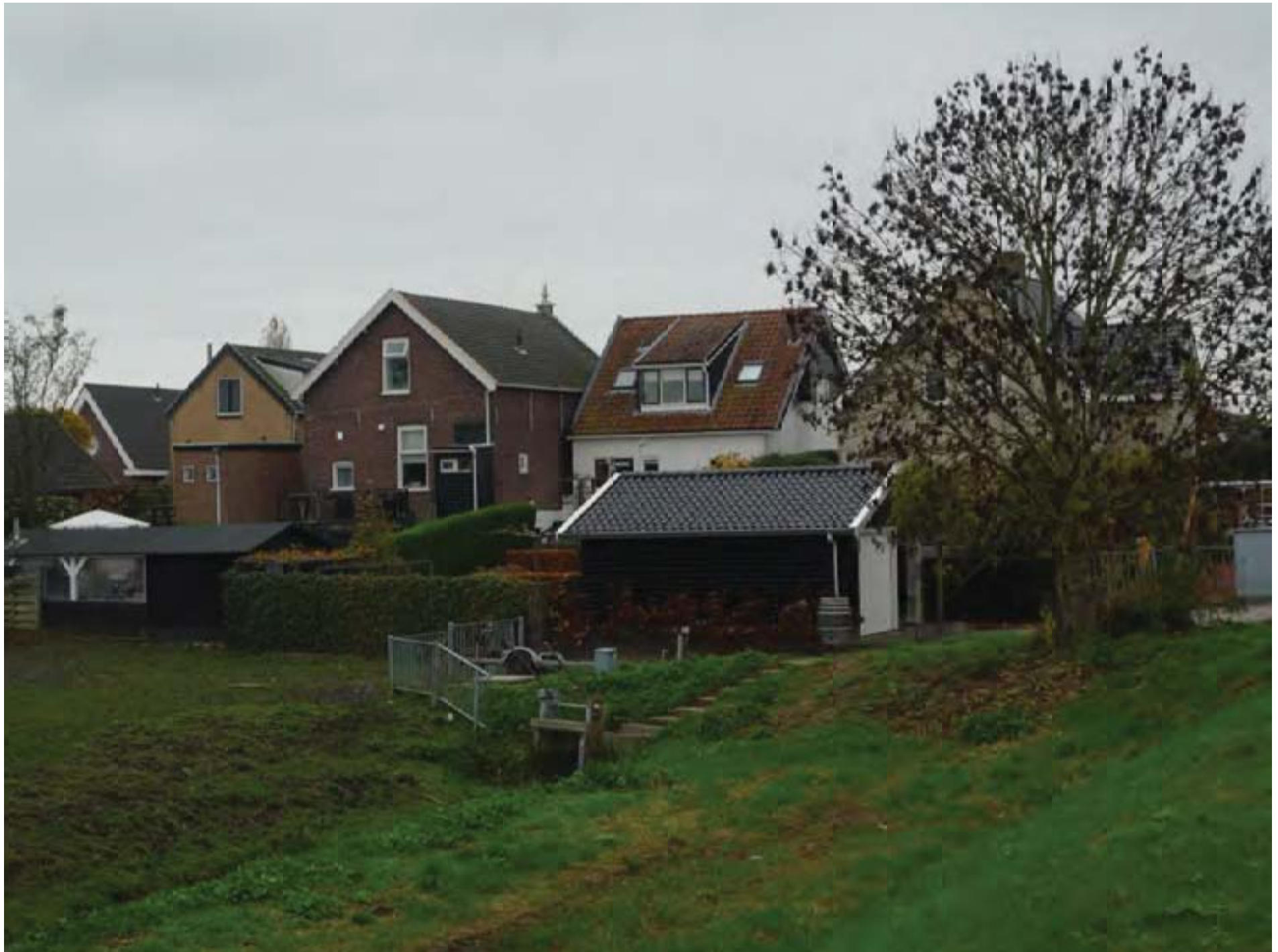
Damstraat 3, 5, 7 en 9 achtergevel (2)
