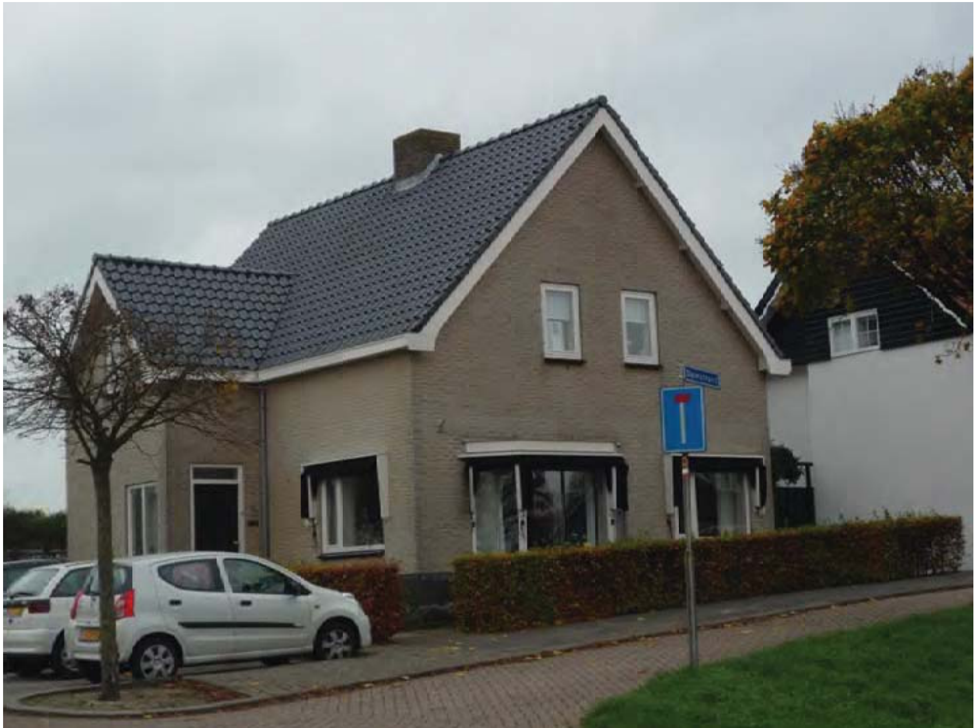
Damstraat 3 linkerzijgevel en voorgevel
