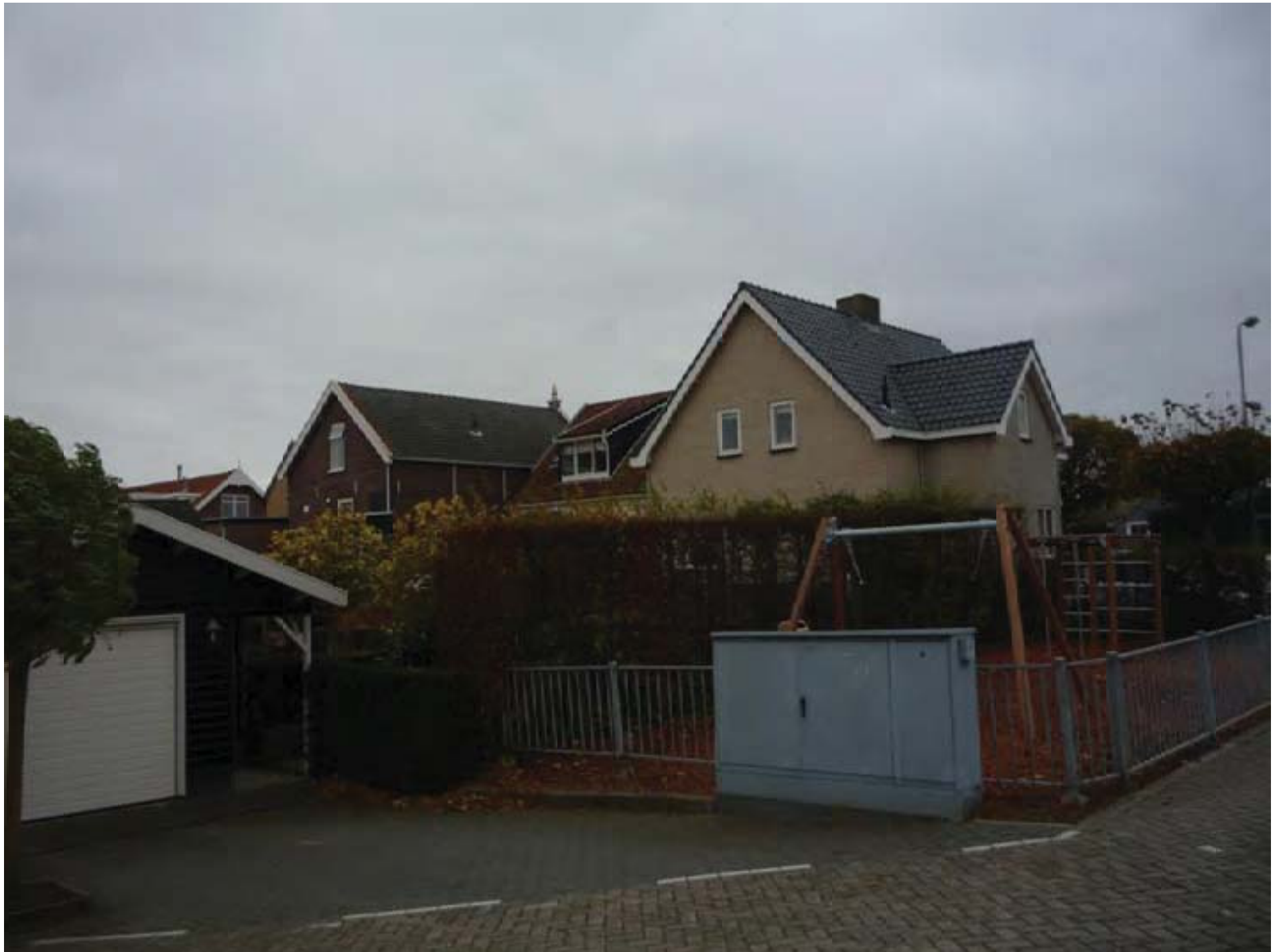
Damstraat 3, 5, 7 en 9 achtergevel
