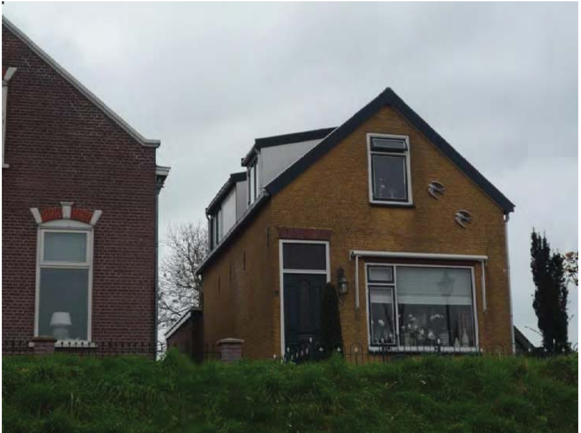
Damstraat 9 linker zijgevel
