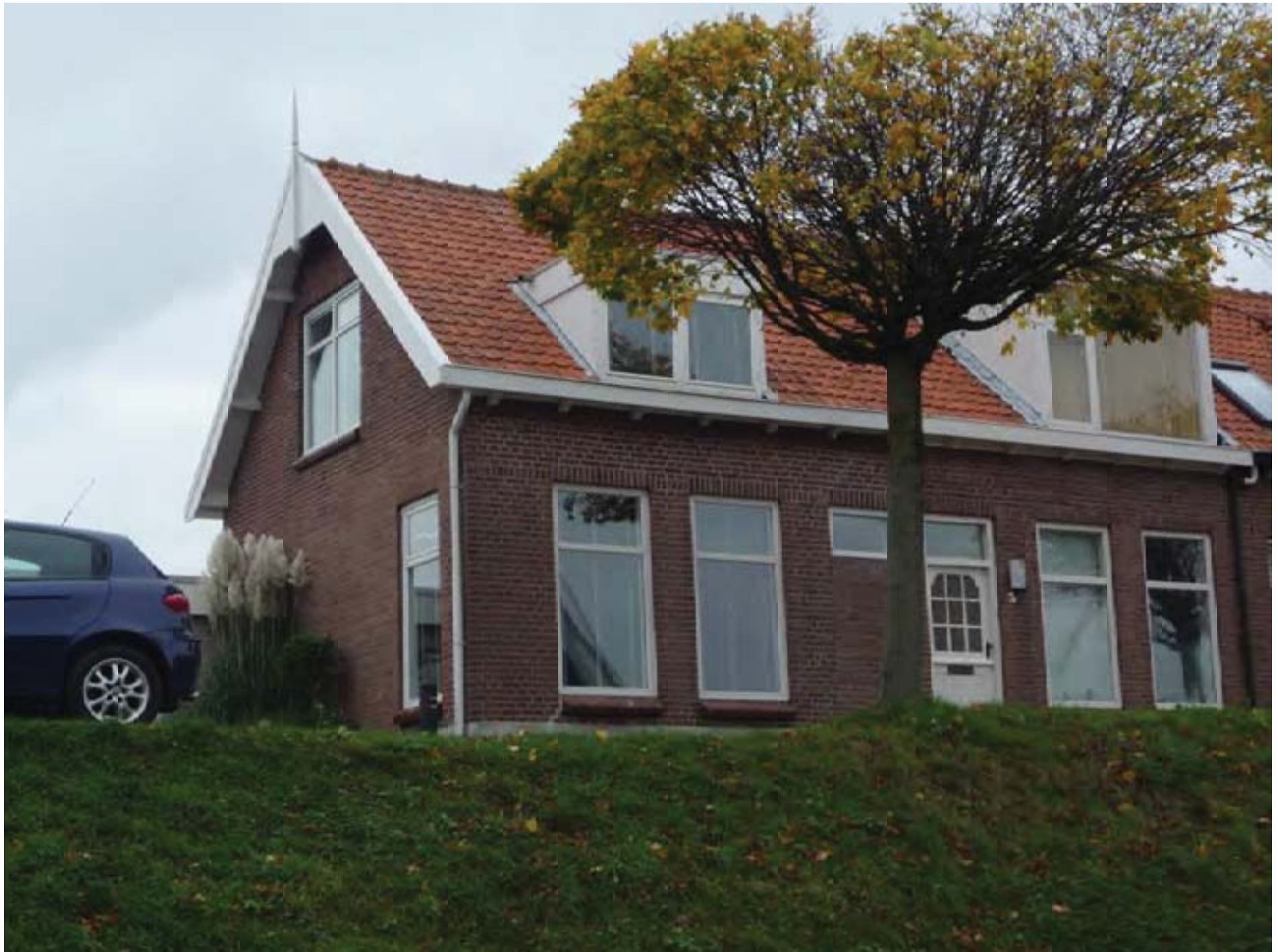
Damstraat 11 linker zijgevel
