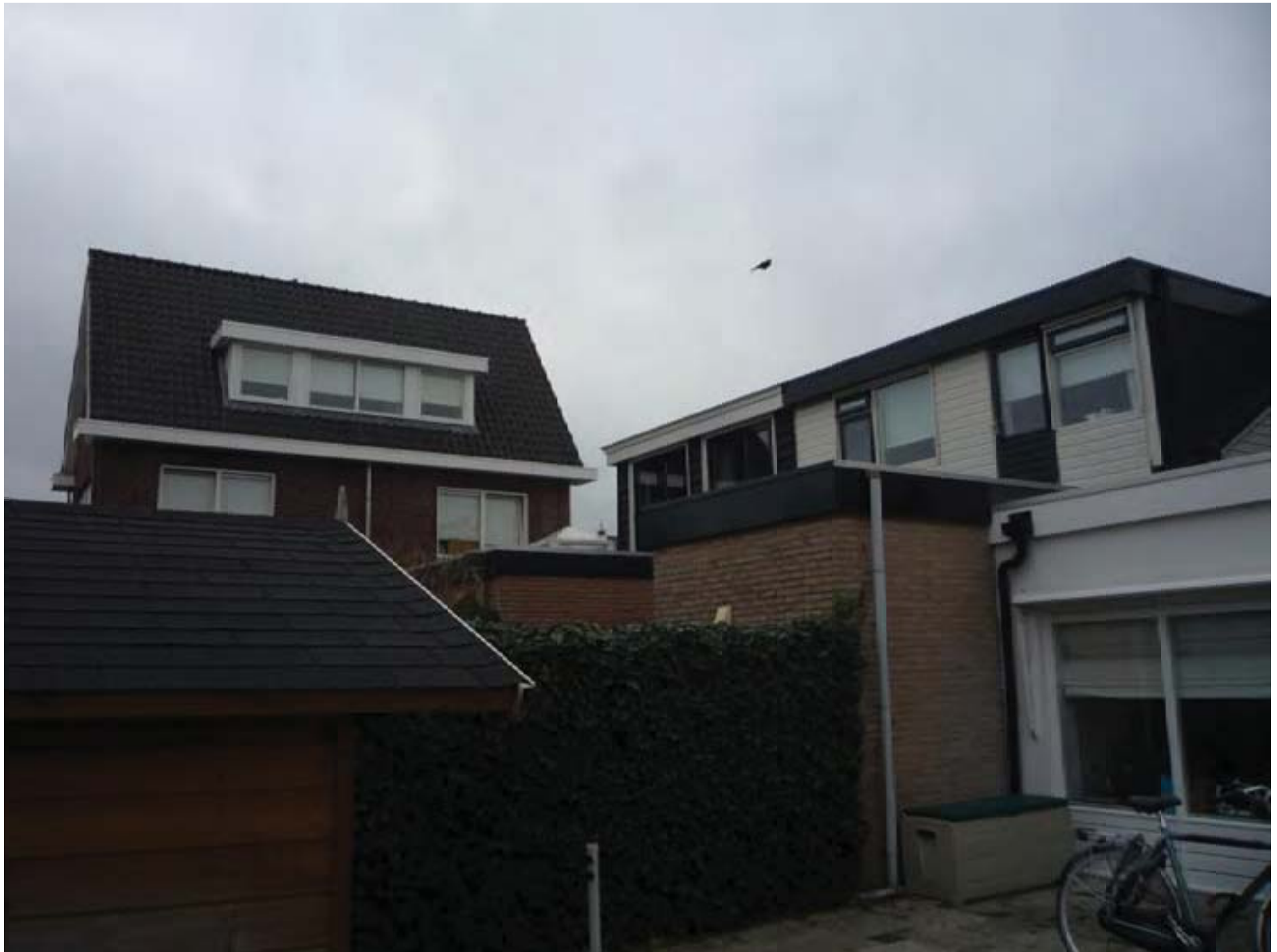
Damstraat 20, 24 en 26 achtergevel
