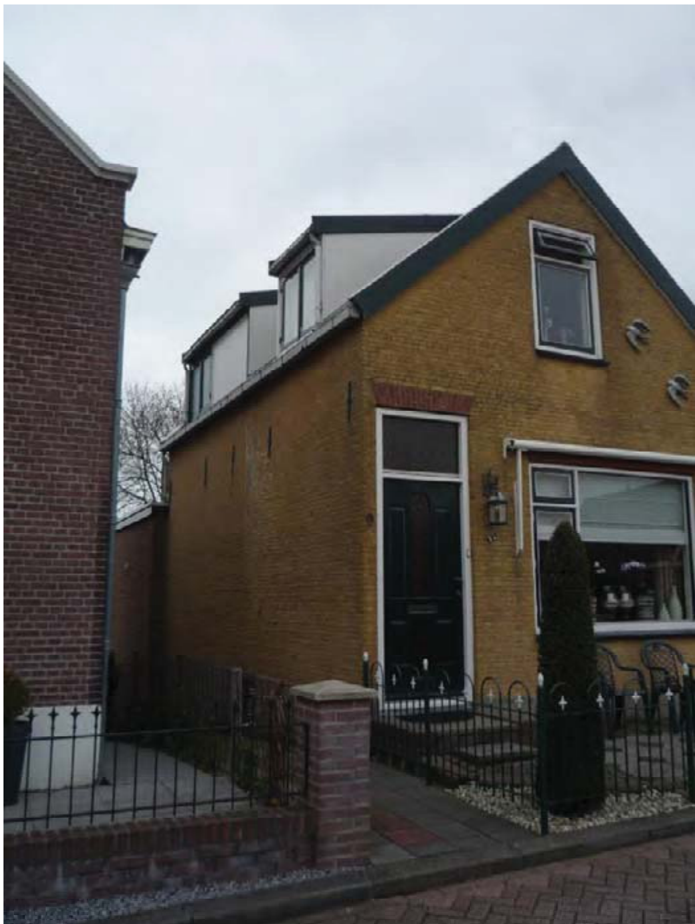
Damstraat 9 linker zijgevel (2)
