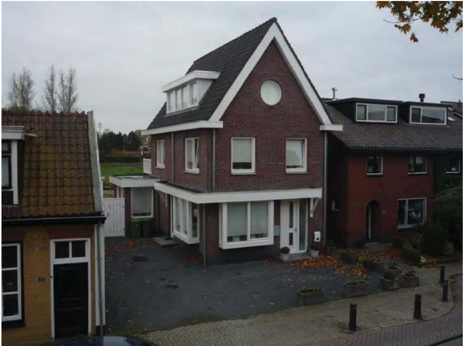
Damstraat 20 linker zijgevel
