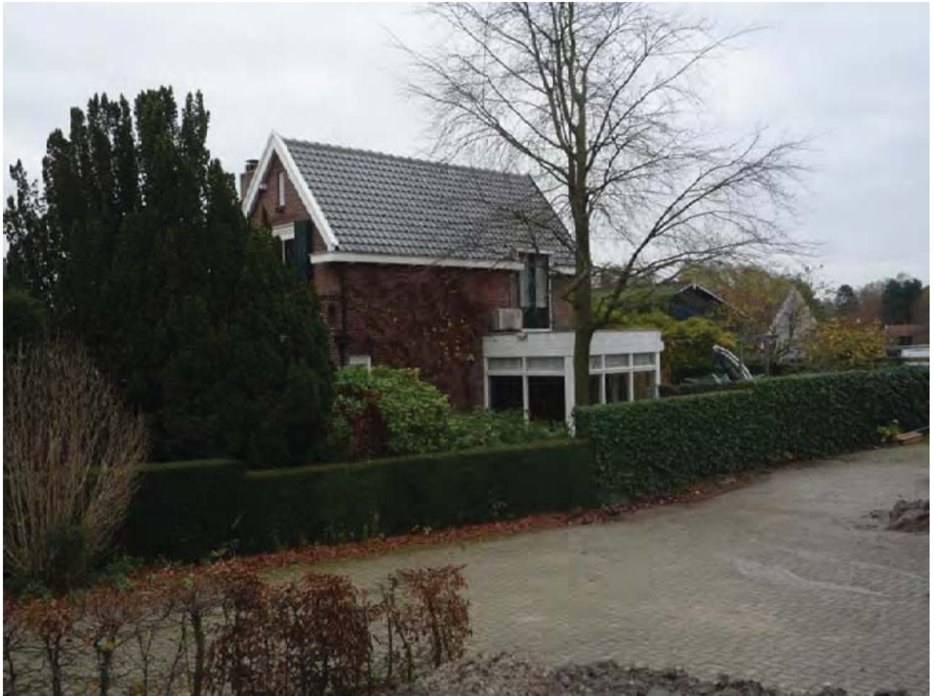
Damstraat 8 rechter zijgevel
