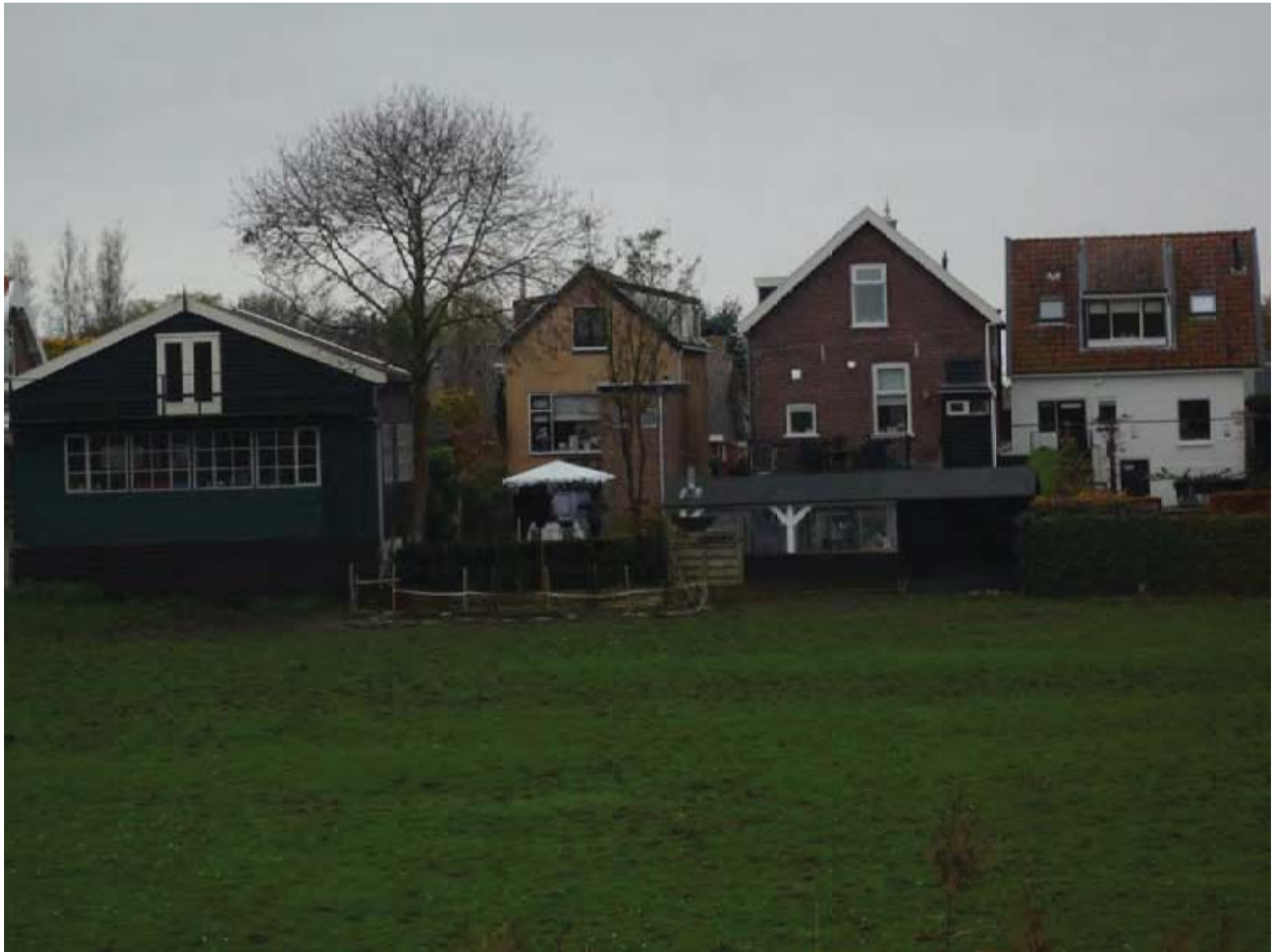
Damstraat 5, 7 en 9 achtergevel
