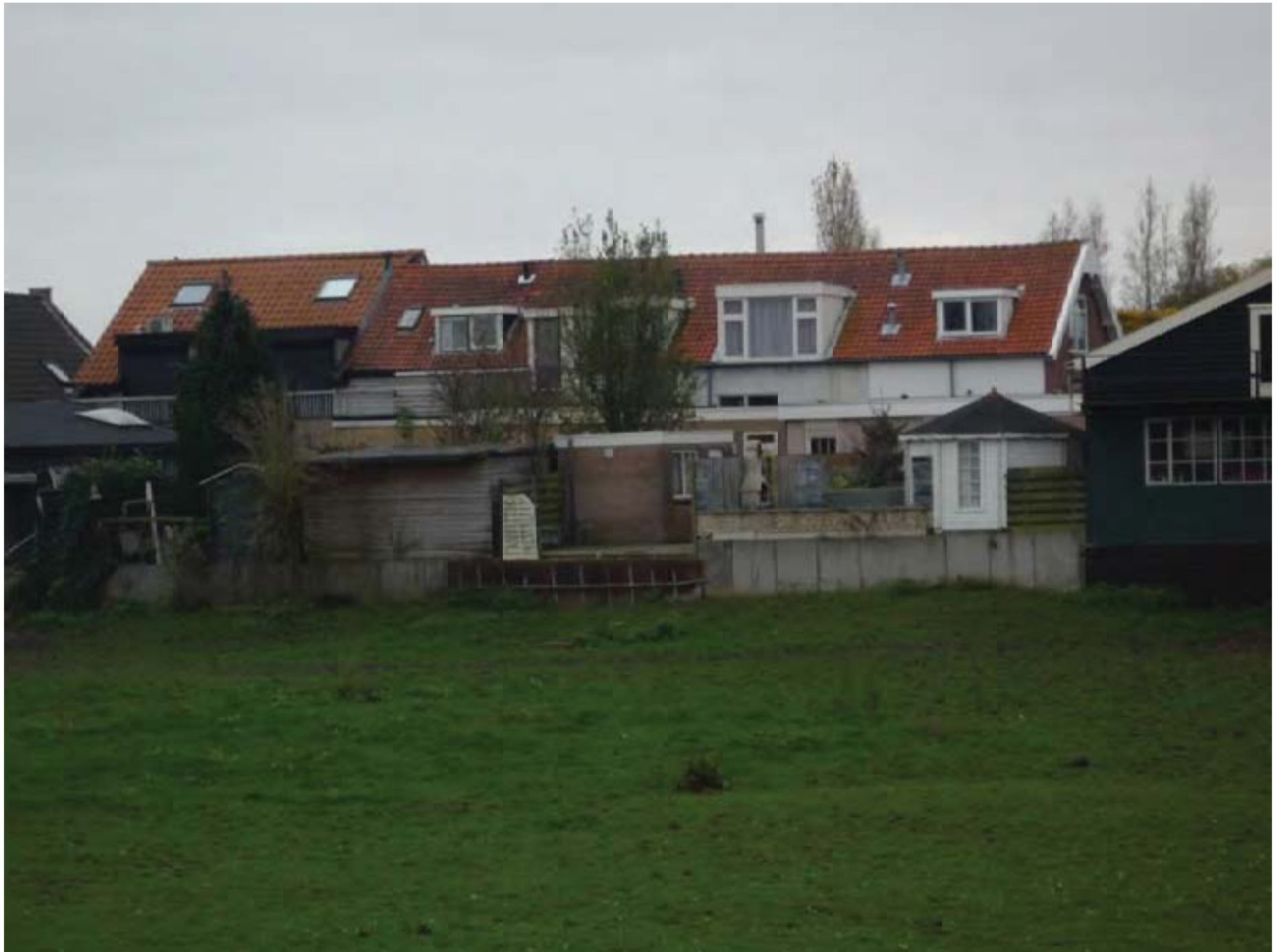
Damstraat 11, 13 en 15 achtergevel
