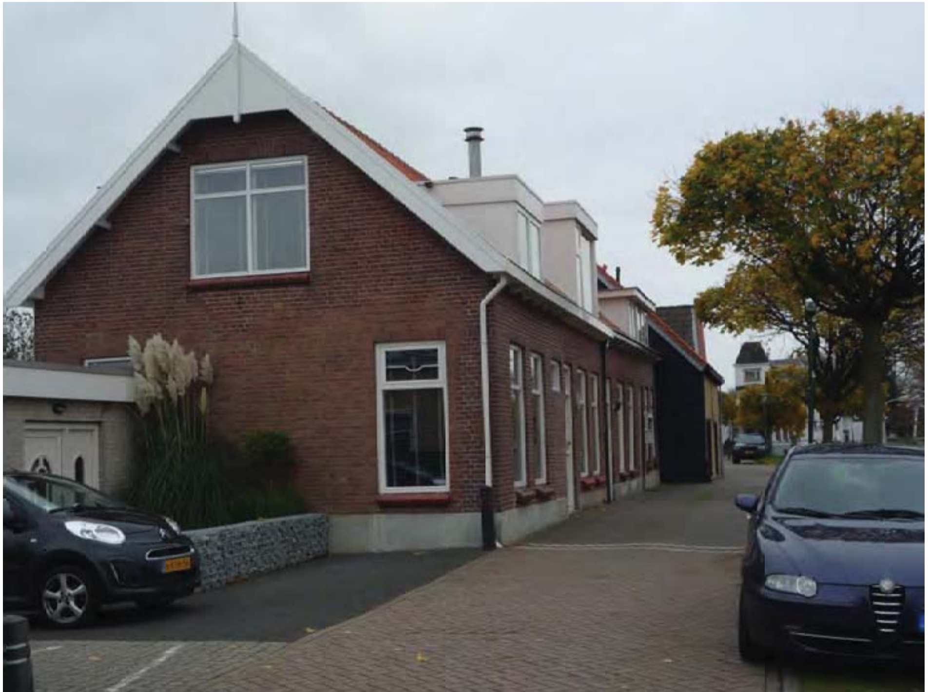
Damstraat 11 linker zijgevel (2)
