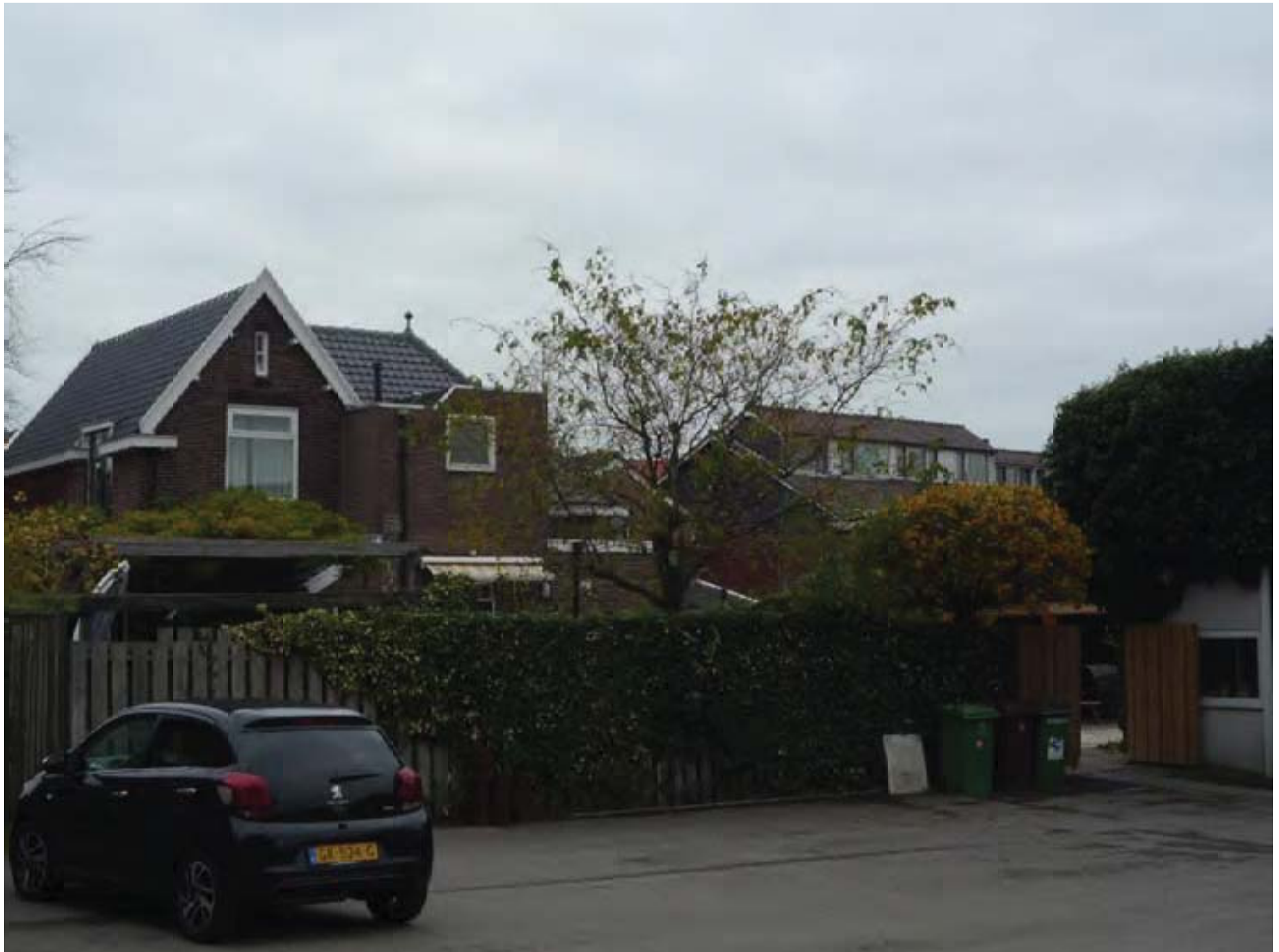
Damstraat 8, 12 en 14 achtergevel
