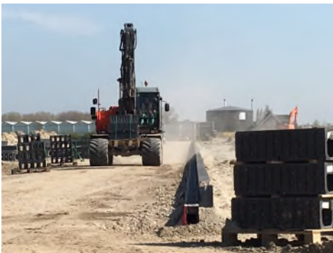
Foto: aanleg Selderijweg
