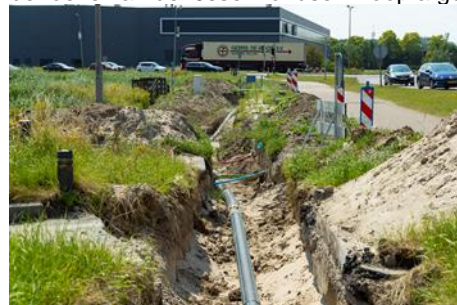
Foto: Verleggen kabels en leidingen (juli 2022)
