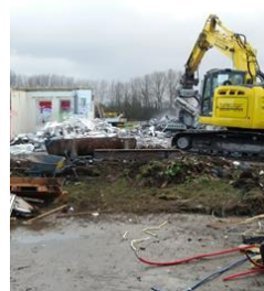
Foto: sloop Voorweg 33 (januari 2022)
