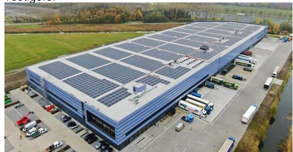
Foto: Het bedrijfspand van ACH is in 2022 BREEAM-NL Excellent-gecertificeerd, er liggen onder andere meer dan 6000 zonnepanelen op het dak.
