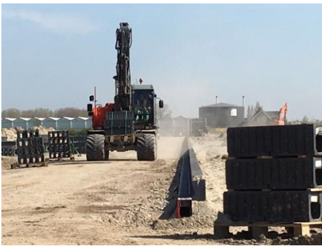
Foto: aanleg Selderijweg
