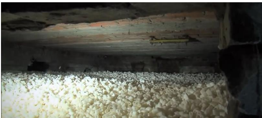
Geïsoleerde kruipkelder met kunststof korrels
