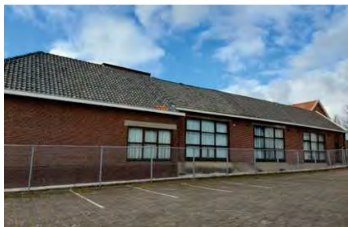
Figuur 10: De achtergevel van de Museumschool.
