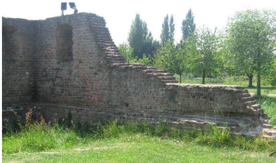
Binnengevelaanzicht van de westgevel
