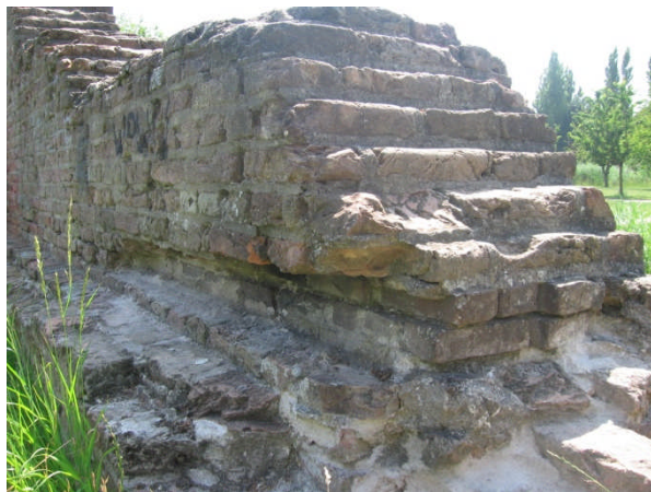
Stenen boven plint in westmuur uitgevallen; plint en afdekking muurwerk oostgevel beschadigd en los
