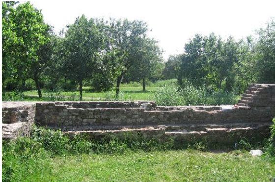
Binnengevelaanzicht van de zuidgevel
