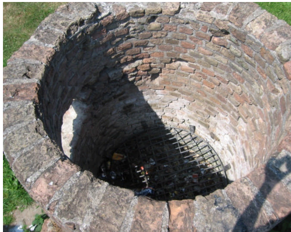
Waterput beklad en beschadigd; afde krooster naar binnen gevallen; interieur vervuild met afval en beschadigd door brand
