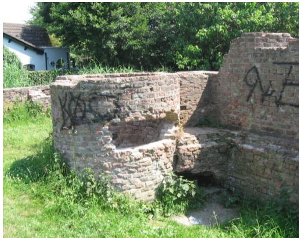
Waterput beklad en beschadigd; afde krooster naar binnen gevallen; interieur vervuild met afval en beschadigd door brand
