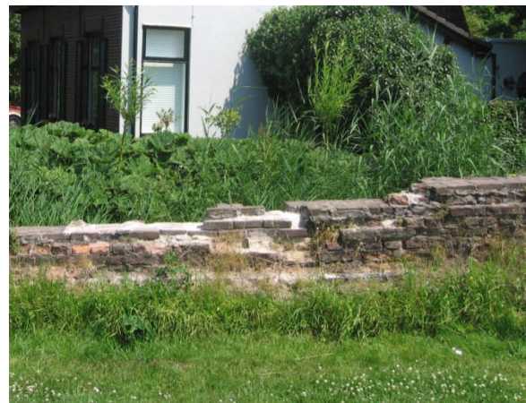
Stenen boven plint in westmuur uitgevallen; plint en afdekking muurwerk oostgevel beschadigd en los
