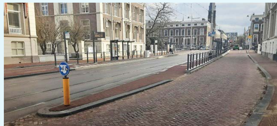
Aangepaste tramhalte Mauritskade in Den Haag
