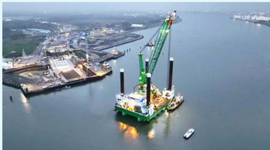
Aanleg tunnel in de Blankenburgverbinding. Foto: Rijkswaterstaat
