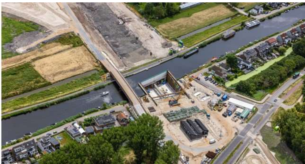
Aanleg tunnel onder de Rotte. Foto: Rijkswaterstaat
