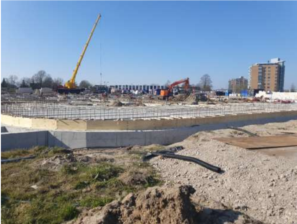
Het eerste van drie bouwblokken in Driehoek Het Zand in aanbouw (maart 2022)
