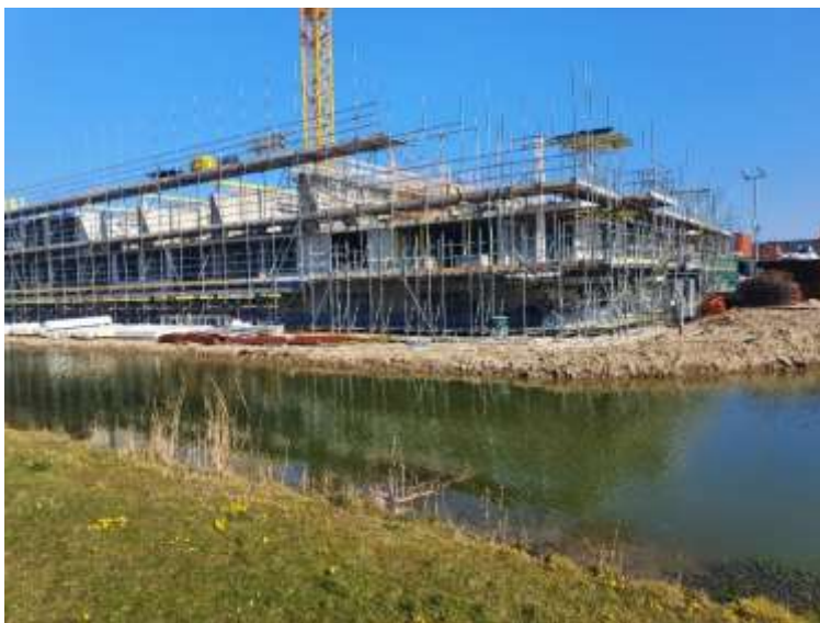
Appartementencomplex fase 6 in aanbouw (maart 2022)
