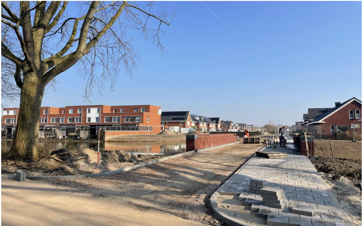
Fietsbrug Het Zand in uitvoering
