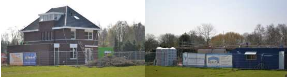
Woningen in aanbouw op de bouwlocatie Legendijk (maart 2017)
