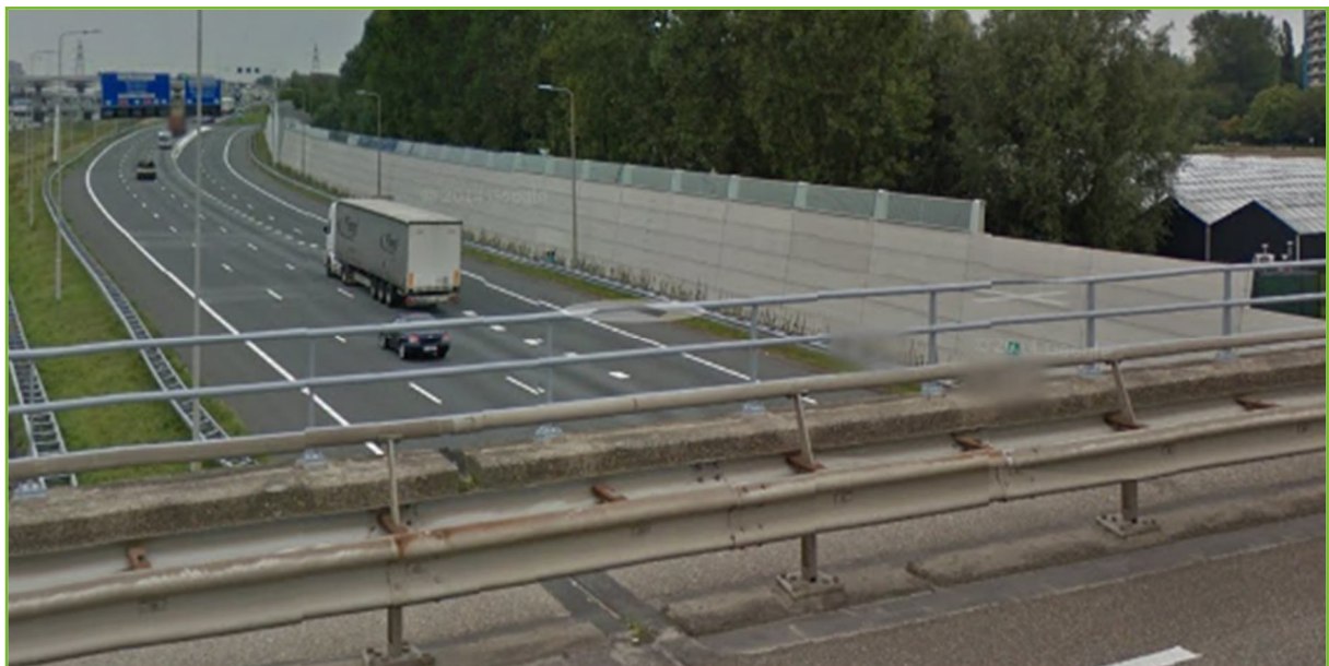
Foto 3.1: Luchtscherm A16 Ridderkerk, gezien vanaf het Populierenviaduct
