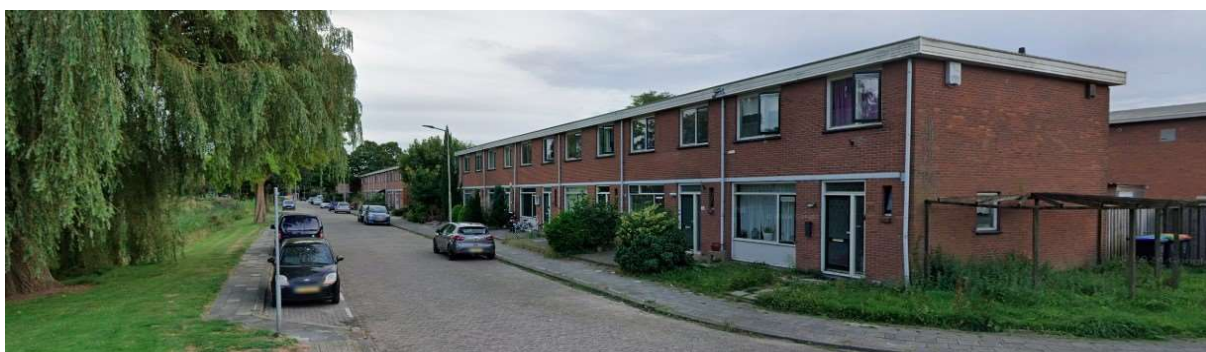
Bestaande situatie (bron: Google streetview, augustus 2024)
