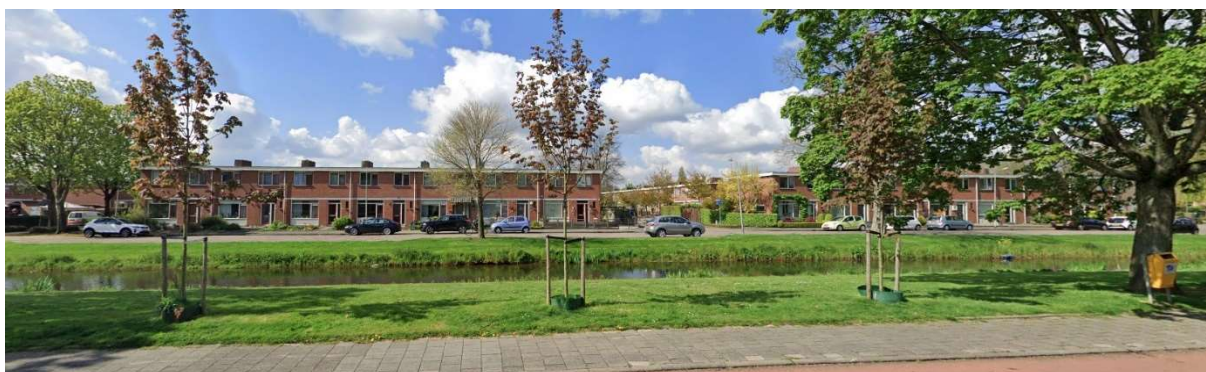
Bestaande situatie, gezien vanaf Burgemeester de Zeeuwstraat (bron: Google streetview, mei 2021)
