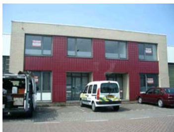
Opgeknapt pand met verbeterde uitstraling in deelgebied C.
