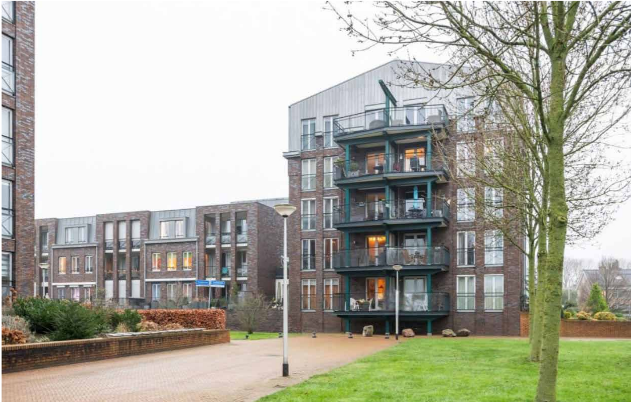
Afbeelding 2.1 Foto van een 5 laags gebouw aan de Diepenbrockstraat in Ridderkerk.
