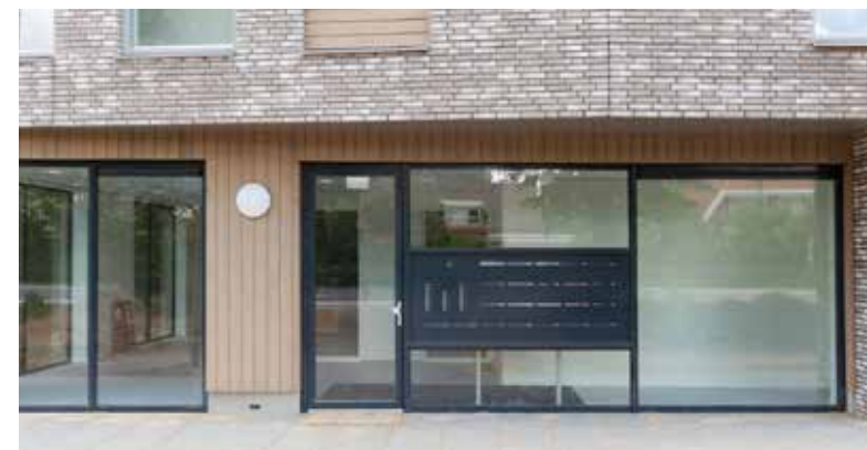
Afbeelding 2.29 Open entree van een portiekflat
