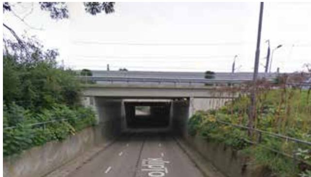
De spoortunnel bij de Noldijk is te smal voor wandelaars.
