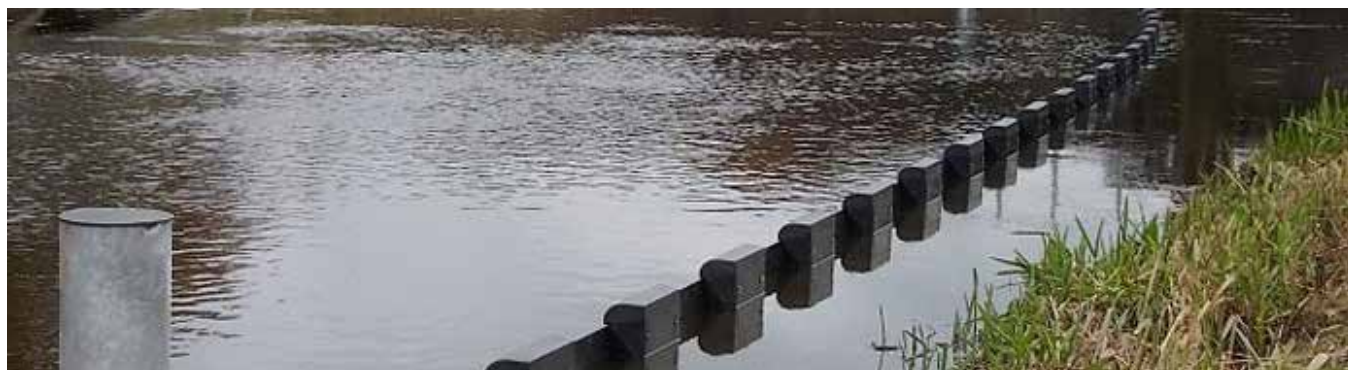
Met een constructie in het water en afgestemd maai-beheer kan de krabbescheer in toom worden gehouden.
