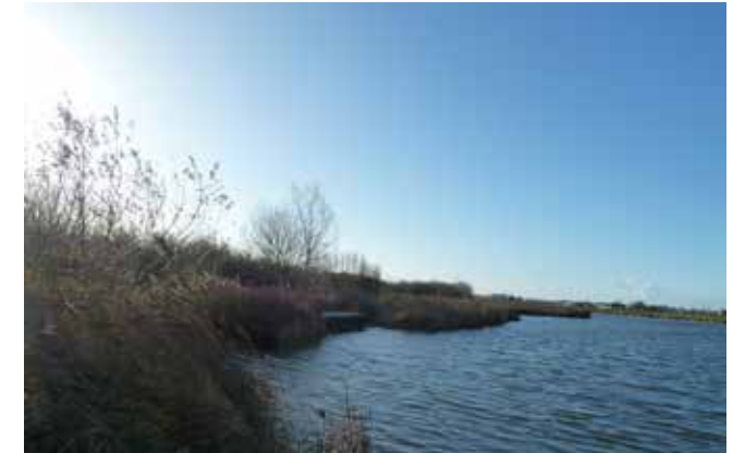
De nieuwe watergang wordt in combinatie met natuurvriendelijke (riet) oevers aangelegd.
