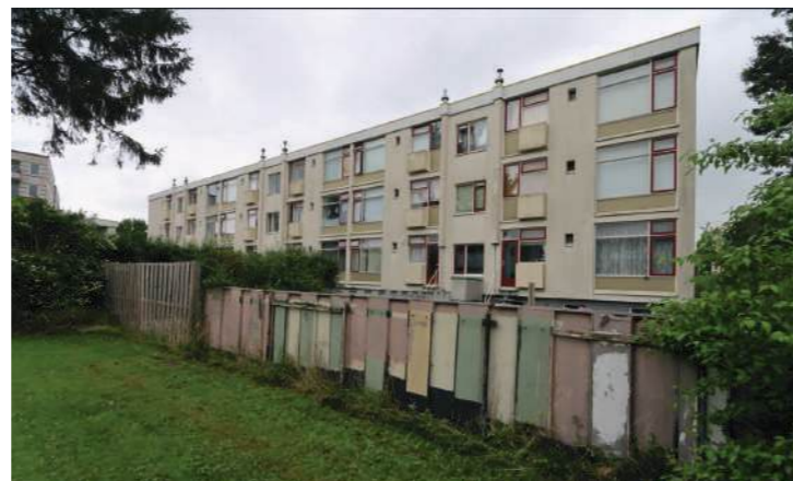
bestaande overgangen van privé naar openbaar
