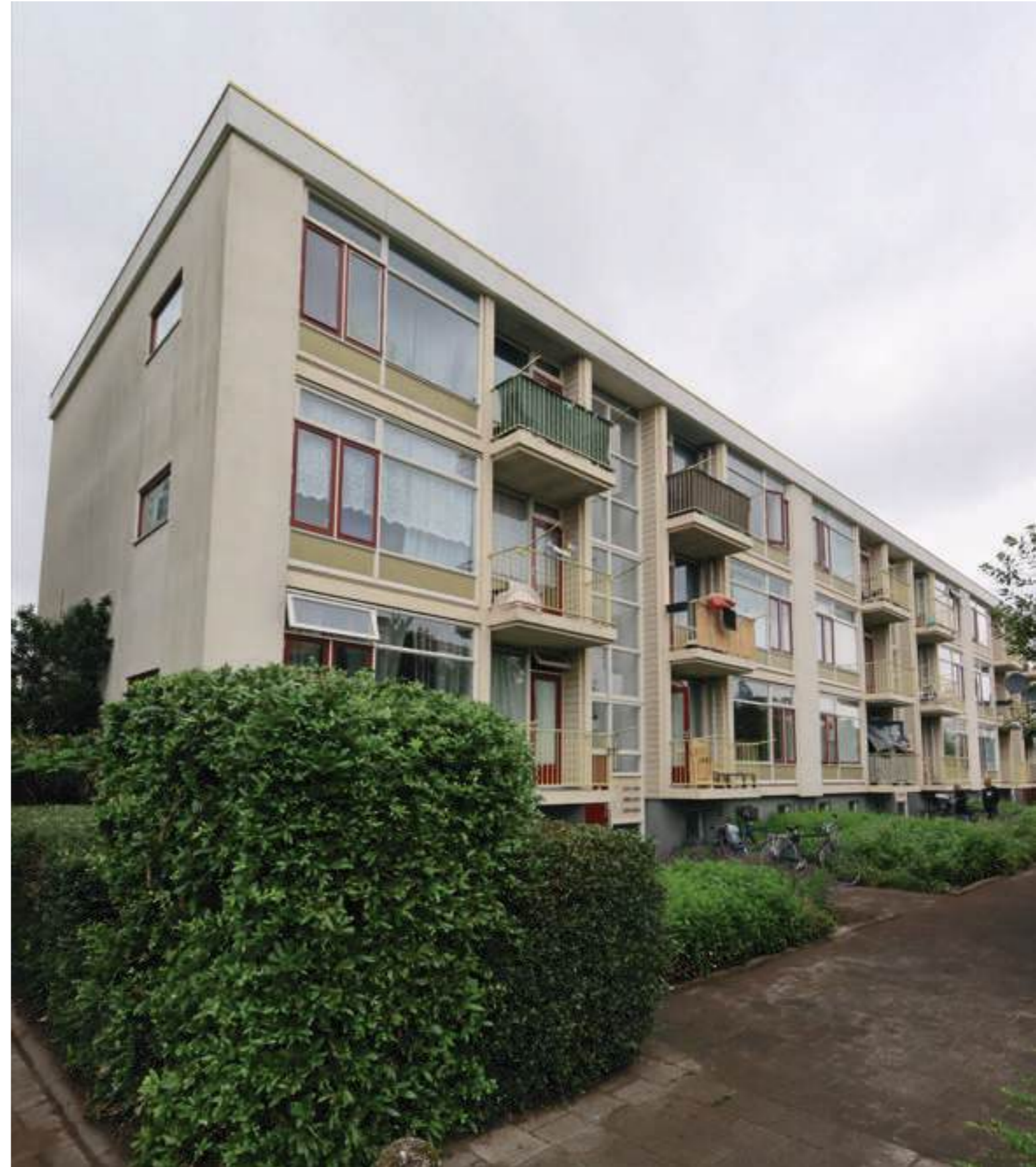
De bestaande bebouwing op de locatie
