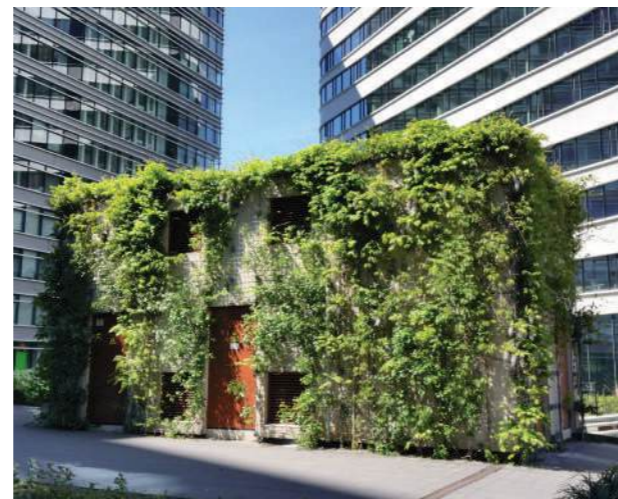
transformator met groene omkleeding
