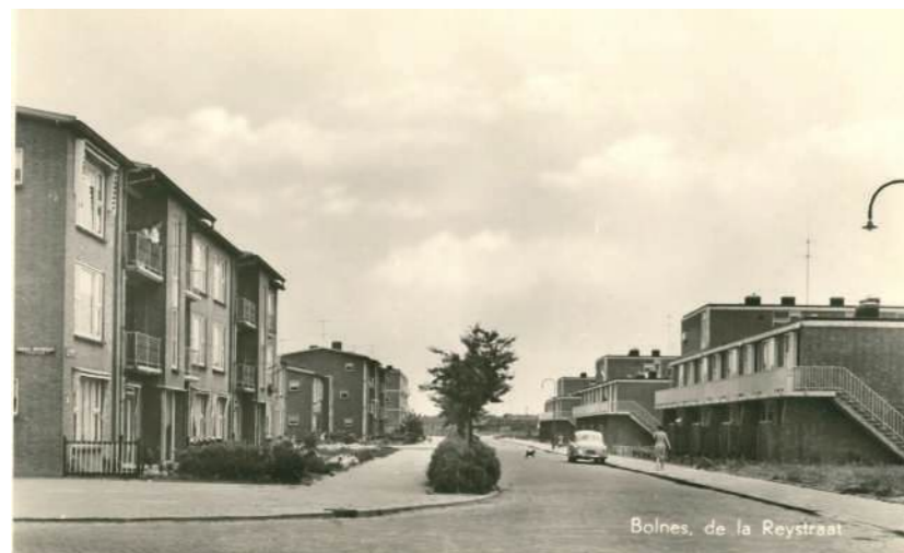
De la Reystraat: vlak na oplevering
