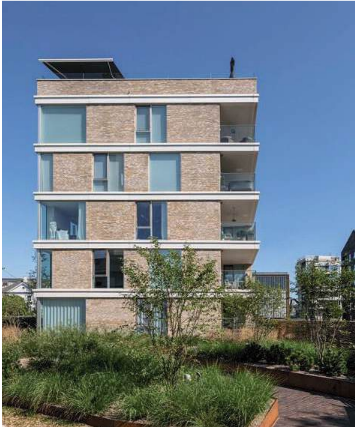
metselwerk als hoofdmateriaal, gecombineerd met een secundair materiaal
