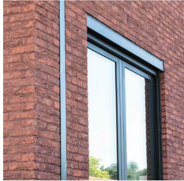
hemelwaterafvoer verzonken in gevel
