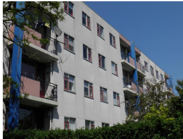
Figuur 3. De achterzijde van de portiekflats.
