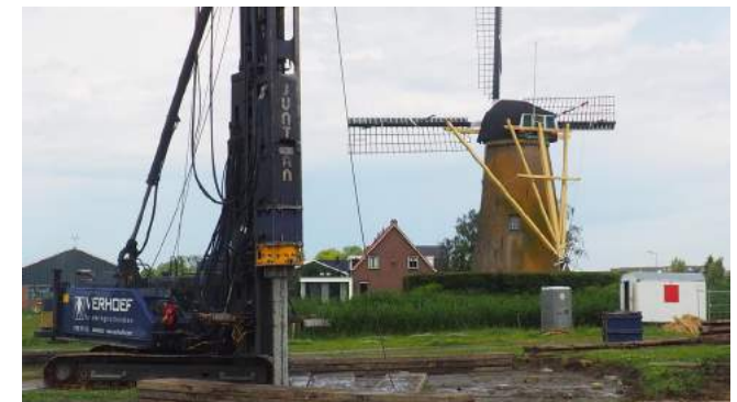
De bouw van het bezoekerscentrum is gestart
