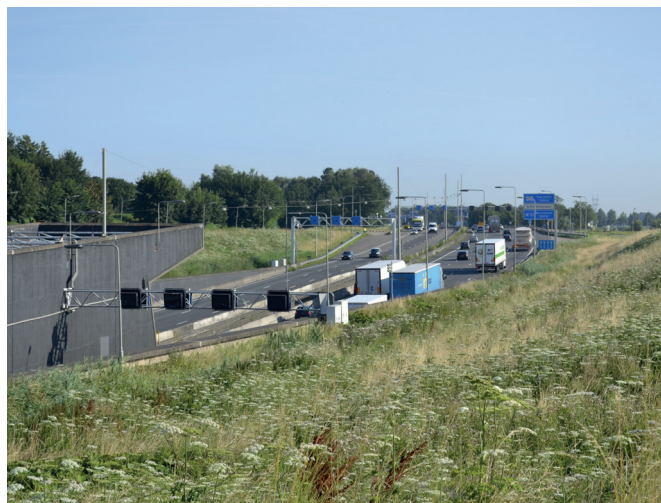
A29 ter hoogte van de Heinoordtunnel
