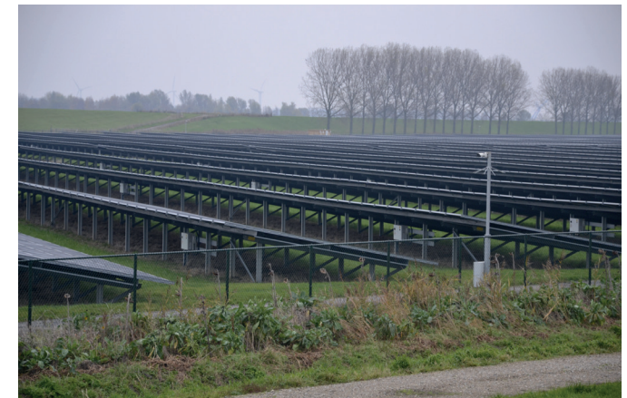
Zicht op de constructie geeft een onrustig beeld.
