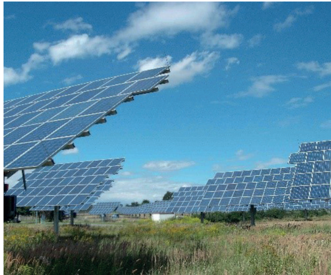
Ruime maat tussen de panelen
