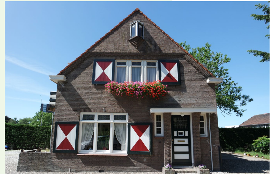
Molensteeg 34 (1927), met typerende architectonische details voor de bouwtijd, zoals het driehoekig venster in de top, glas in lood in de ramen en verbijzondering van het metselwerk.
