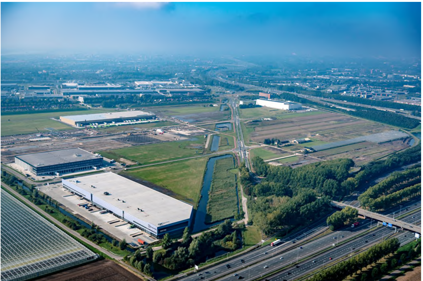
Foto: luchtfoto van Nieuw Reijerwaard uit 2021 (Boomerang)
