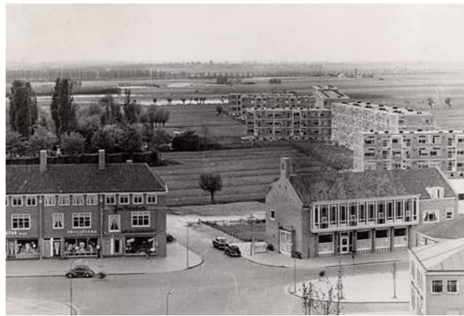
Complex Rembrandtweg vormde de rand van het centrum (beeld vlak na bouw)
