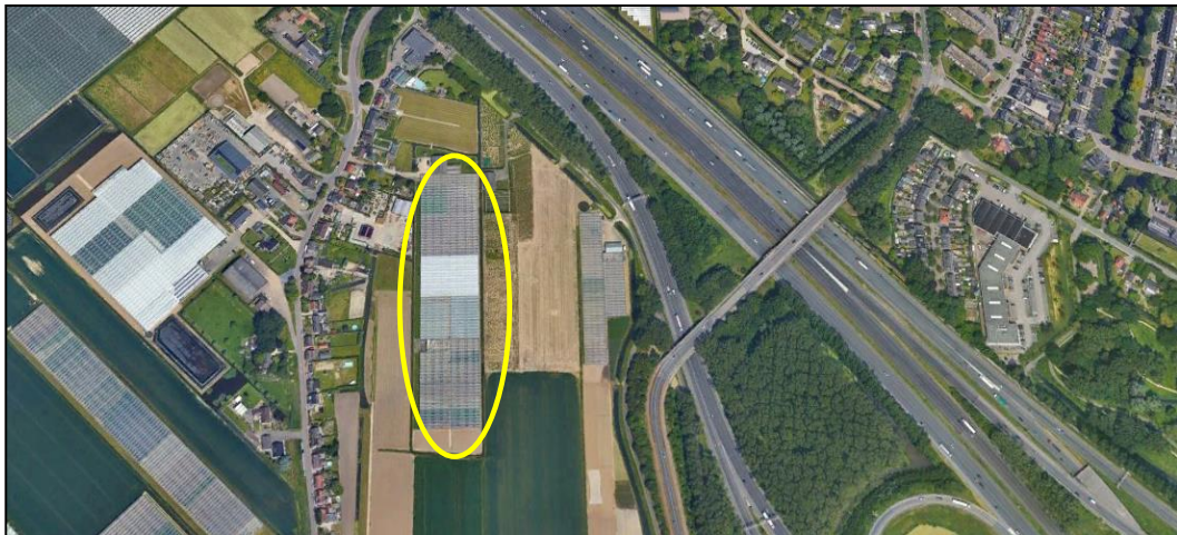
Figuur 2.1: Saneringslocatie glastuinbouw Lagendijk 285 Ridderkerk.
