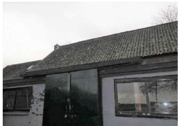
Figuur 19 Zijgevel dak schuur
