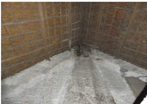
Figuur 20 Binnenzijde dak schuur
