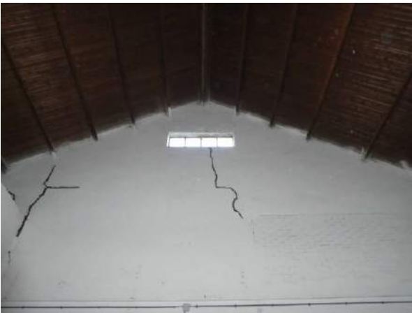
Figuur 26 Binnenzijde dakconstructie loods
