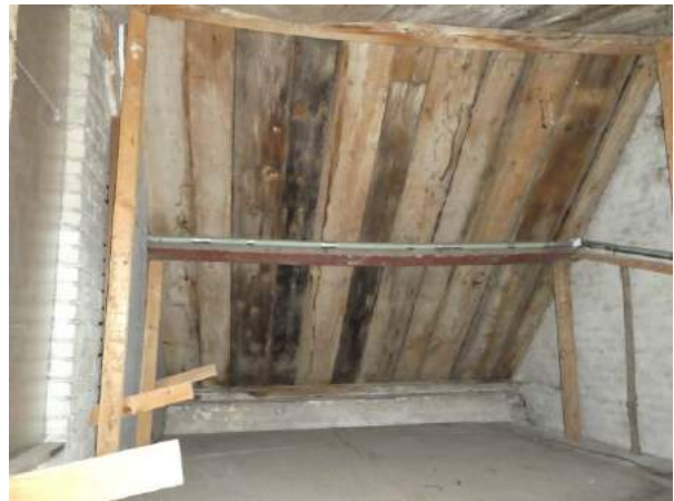
Figuur 16 Dakconstructie binnenzijde pand
