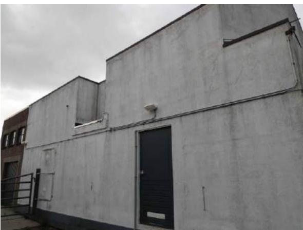
Figuur 24 Achterzijde loods
