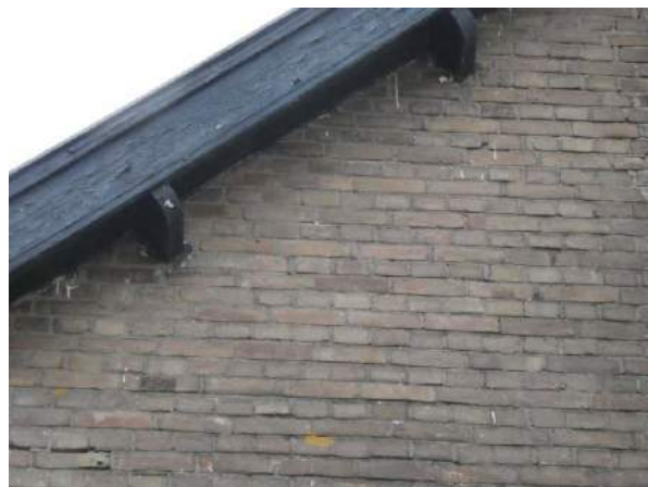
Figuur 23 Detail daktrim
