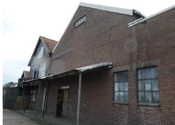
Figuur 25 Achterzijde loods
