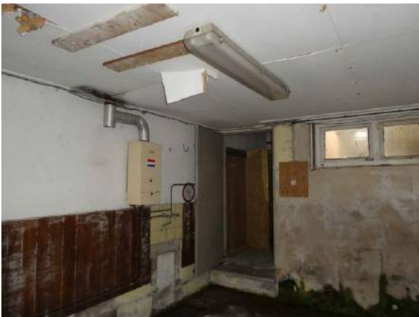
Figuur 15 Binnenzijde pand
