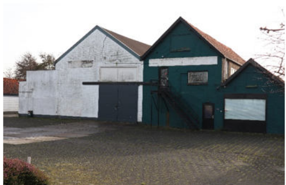
Te slopen bedrijfsbebouwing op nr. 175.
