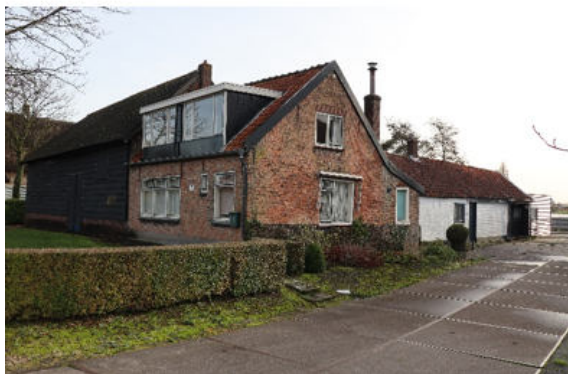
Te slopen bebouwing op nrs. 171 en 173.
