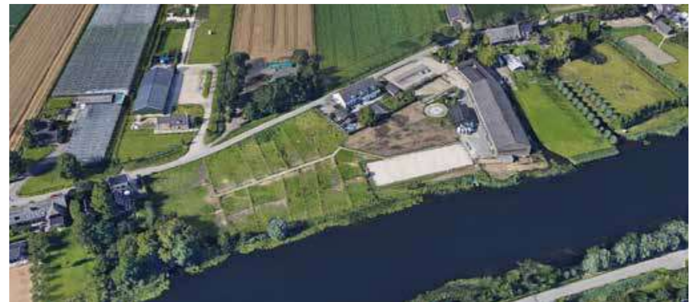
fig. 2. Het perceel aan de Waal bron: Google
