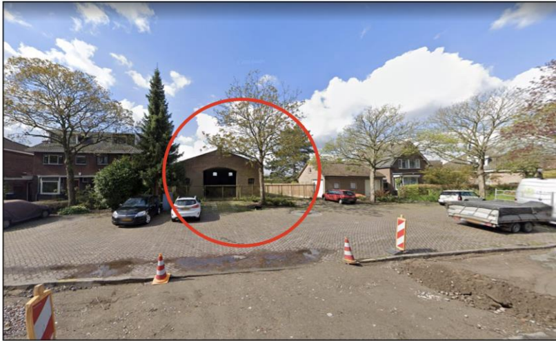
De bestaande, te slopen, schuur, aangeduid binnen de rode cirkel.
