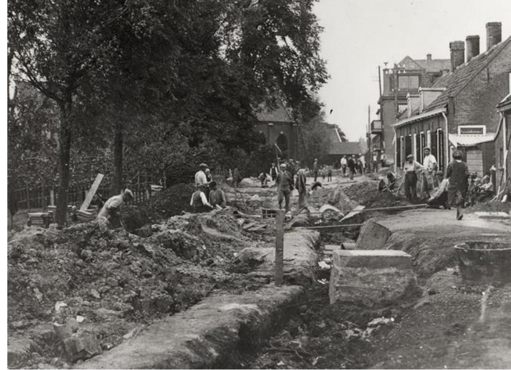
Aanleg riolering Benedenrijweg
