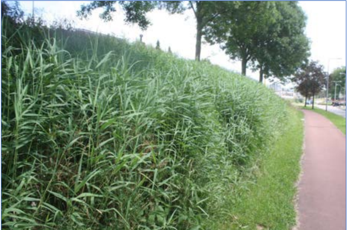
Figuur 33: Dijk Vlietlaan (locatie G op kaart). Hoge (ruige) vegetatie met een dominantie van Rietgras, blijft op zo'n voedselrijke grond in stand met waarschijnlijk (slechts) een keer per jaar maaien en afvoeren.
